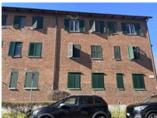
FACCIATA SU VIA PUBBLICA
