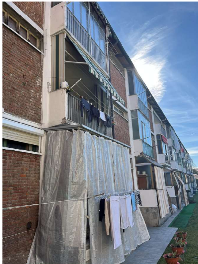
04_facciata su corte interno
