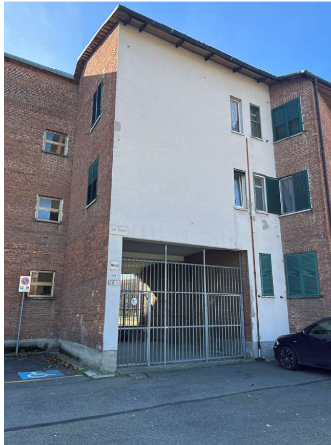
03_ingresso dal civico n. 20
