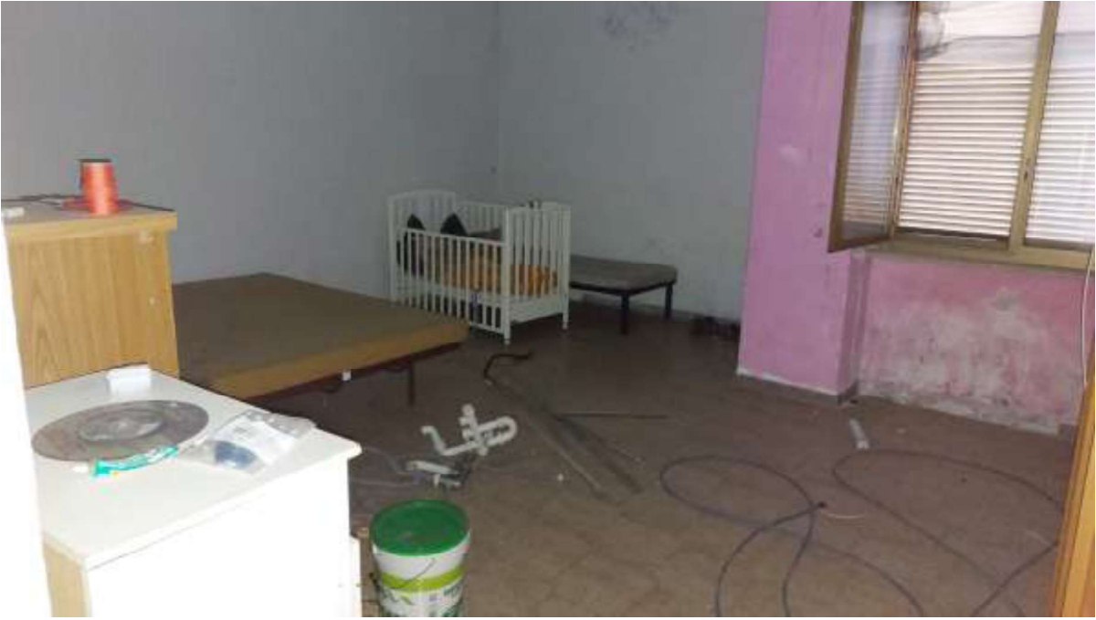
CAMERA AL PIANO TERRA - LATO NO
