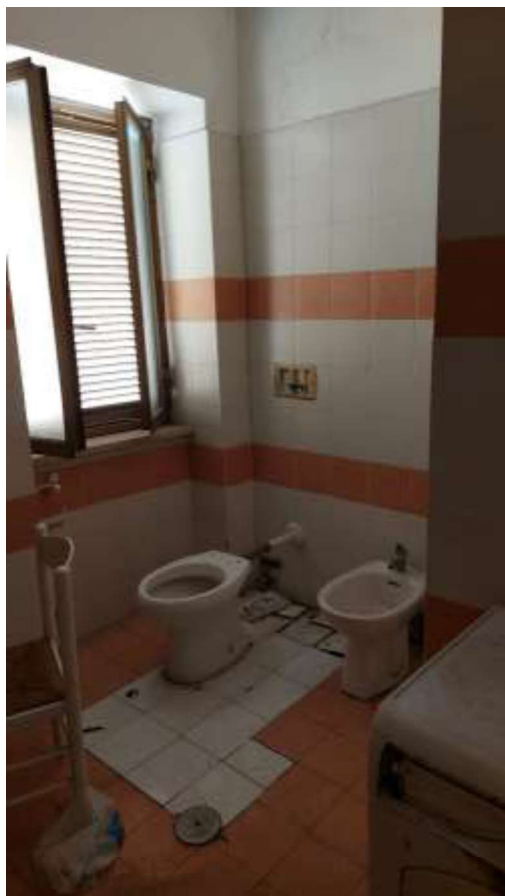
BAGNO 1 – PIANO PRIMO
