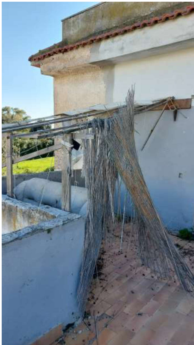
VISTA TERRAZZA AL PIANO PRIMO
