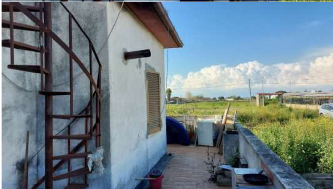
SCALA ESTERNA DI COLLEGAMENTO ALLA COPERTURA
