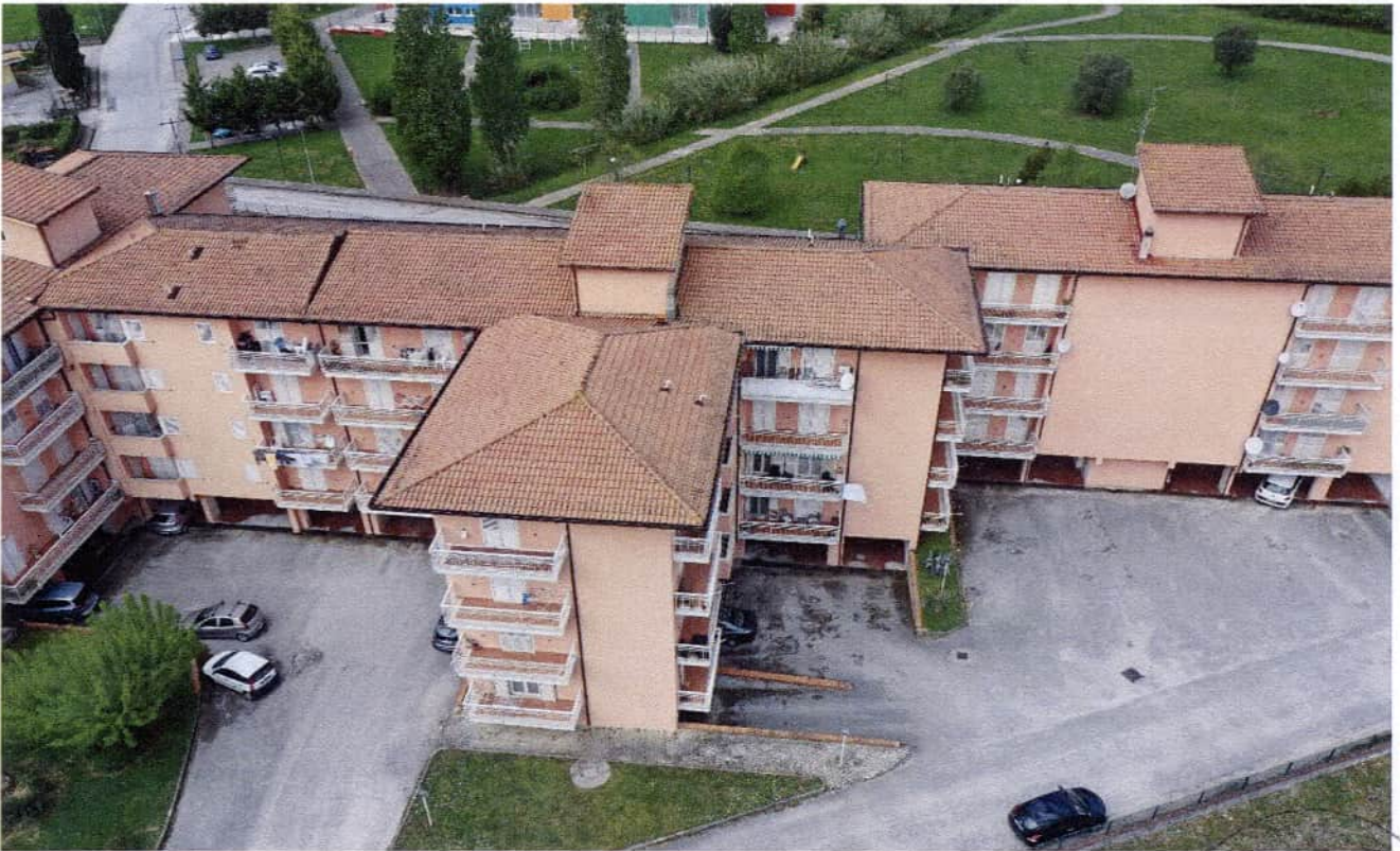
Foto 13: Vista aerea dell'ingresso al garage al piano primo sottostrada in direzione nord-ovest
