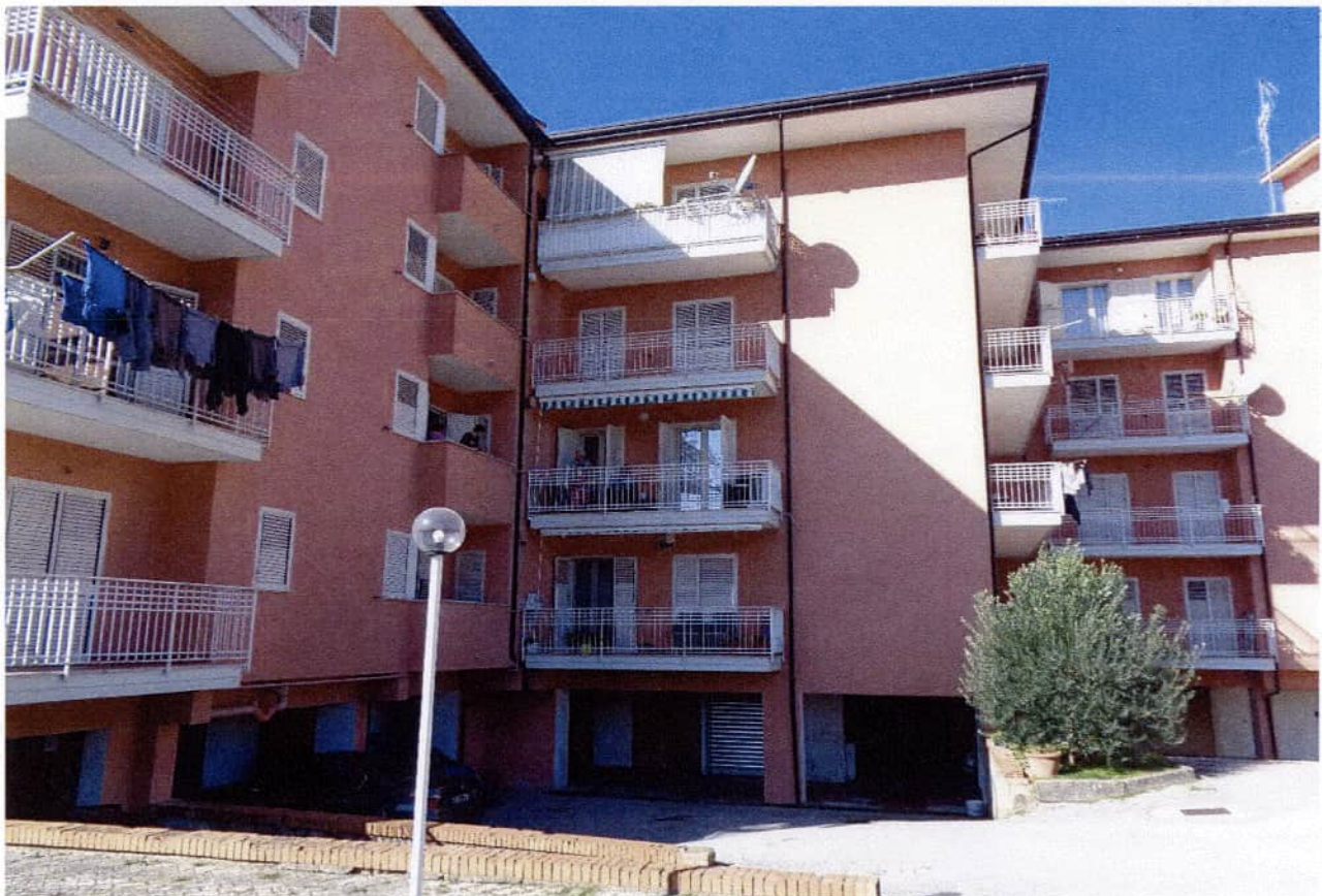
Foto 14: Vista del portone d'ingresso al garage
