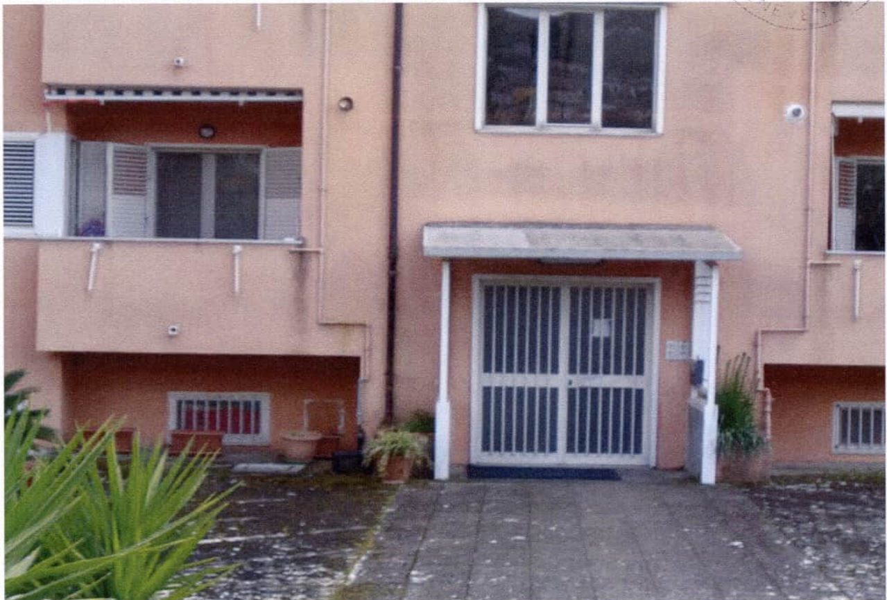
Foto 04: Vista del portone d'ingresso alla scala B
