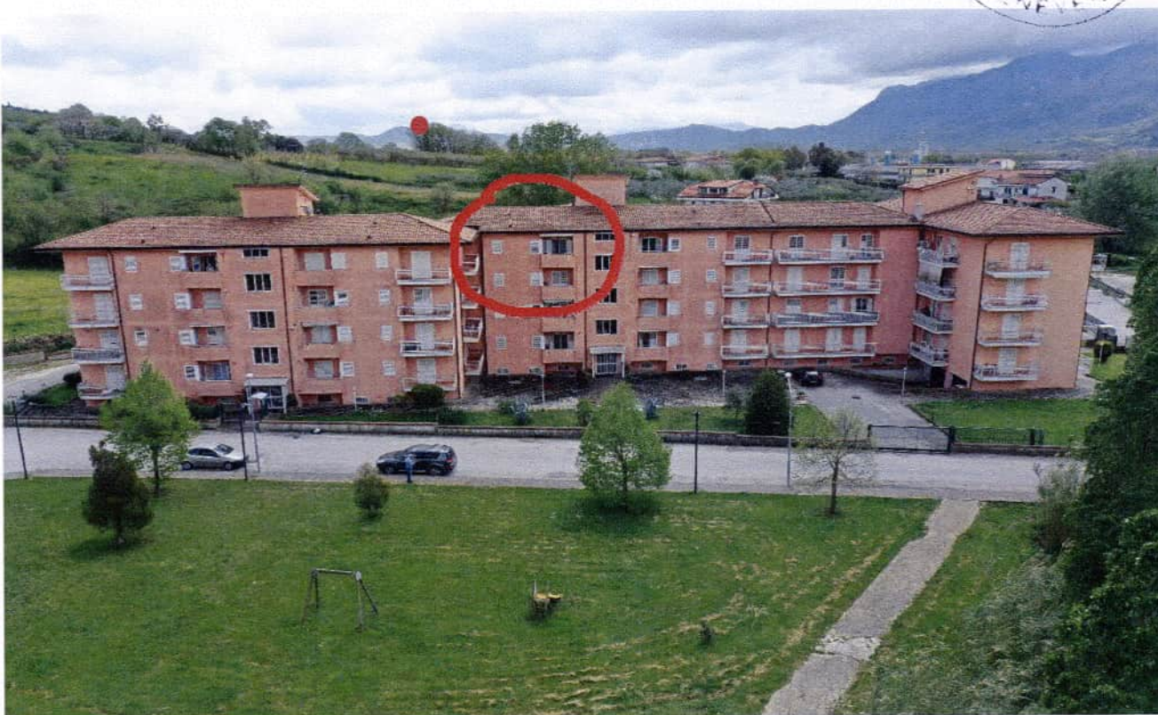
Foto 02: Vista aerea dell'appartamento al piano terzo in direzione sud-est
