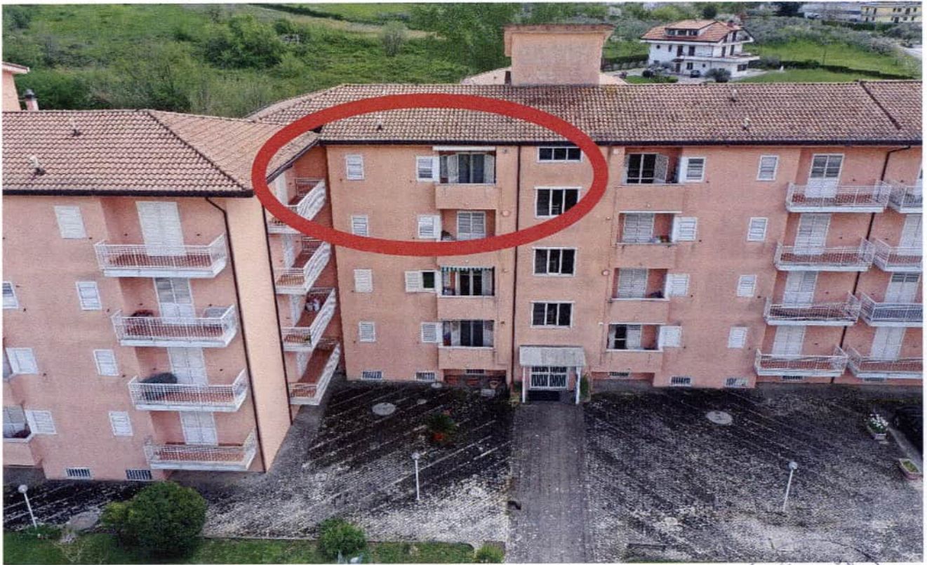
Foto 03: Vista aerea dell'appartamento al piano terzo in direzione sud-est
