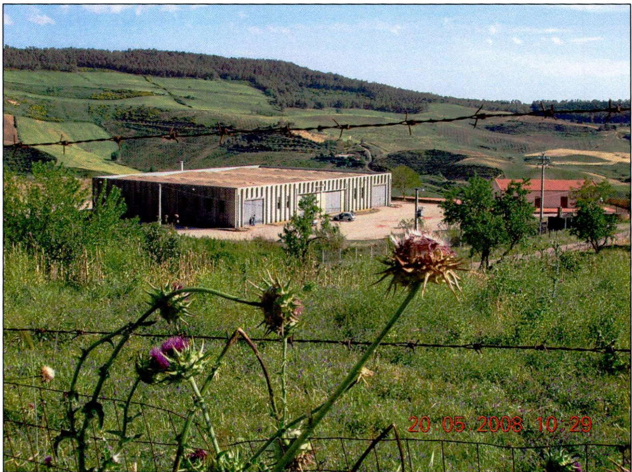
FOTO 1 - GLI IMMOBILI OGGETTO DI PIGNORAMENTO. SI SCORGE A SINISTRA IL CASEIFICIO (P.LLA 312) E A DESTRA IL FABBRICATO DEGLI UFFICI (P.LLA 56) INSISTENTI SULLA P.LLA 215. A SX DEL CASEIFICIO LE P.LLE 37 E 311.
