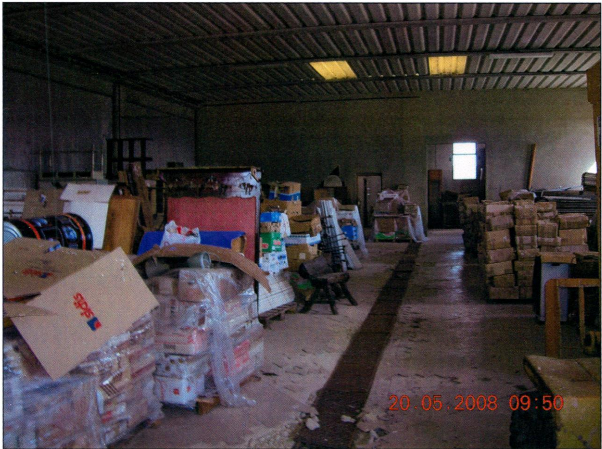
FOTO 11 - IL LOCALE DEDICATO AL RICOVERO AUTOMEZZI. OGGI È USATO COME DEPOSITO.
