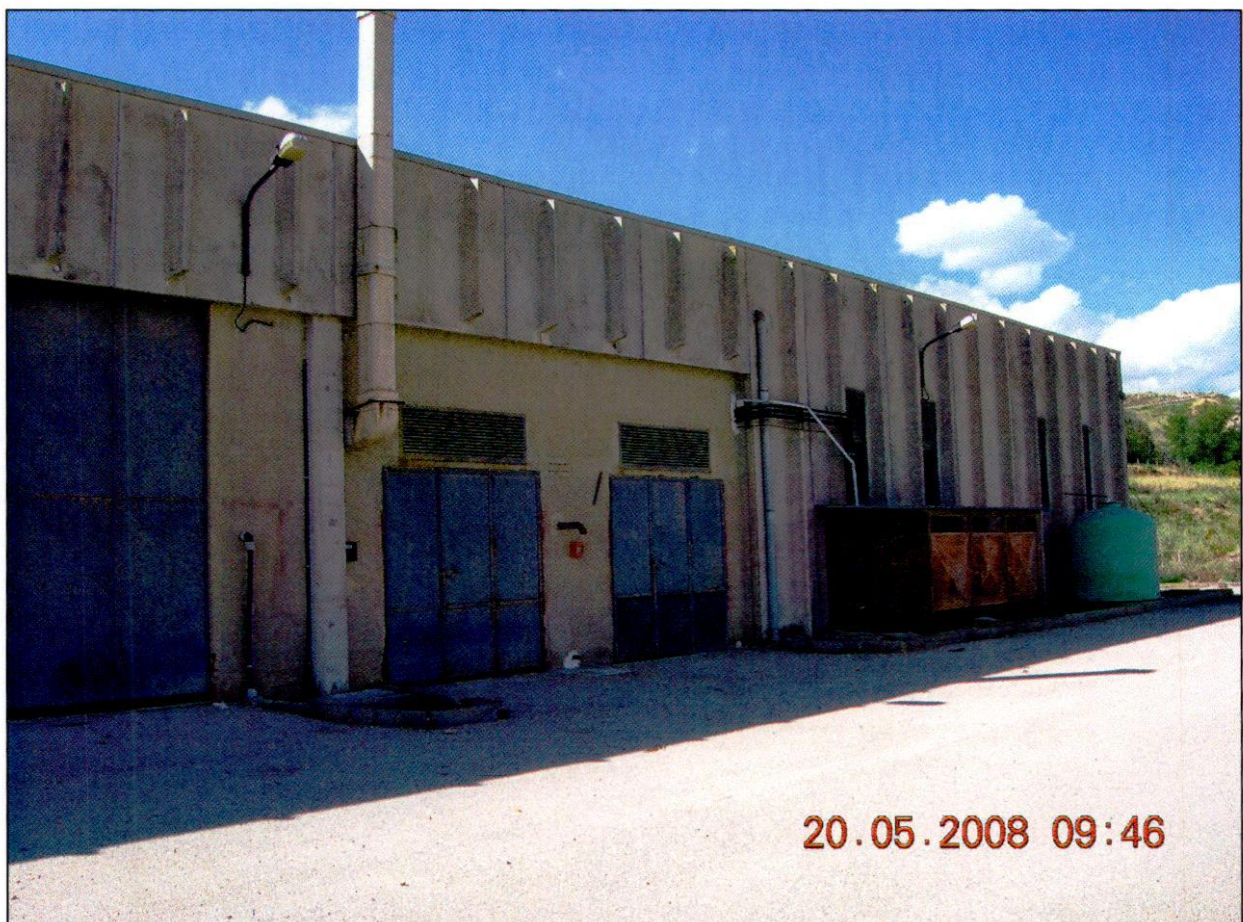
FOTO 2 - IL PROSPETTO SUL RETRO.
