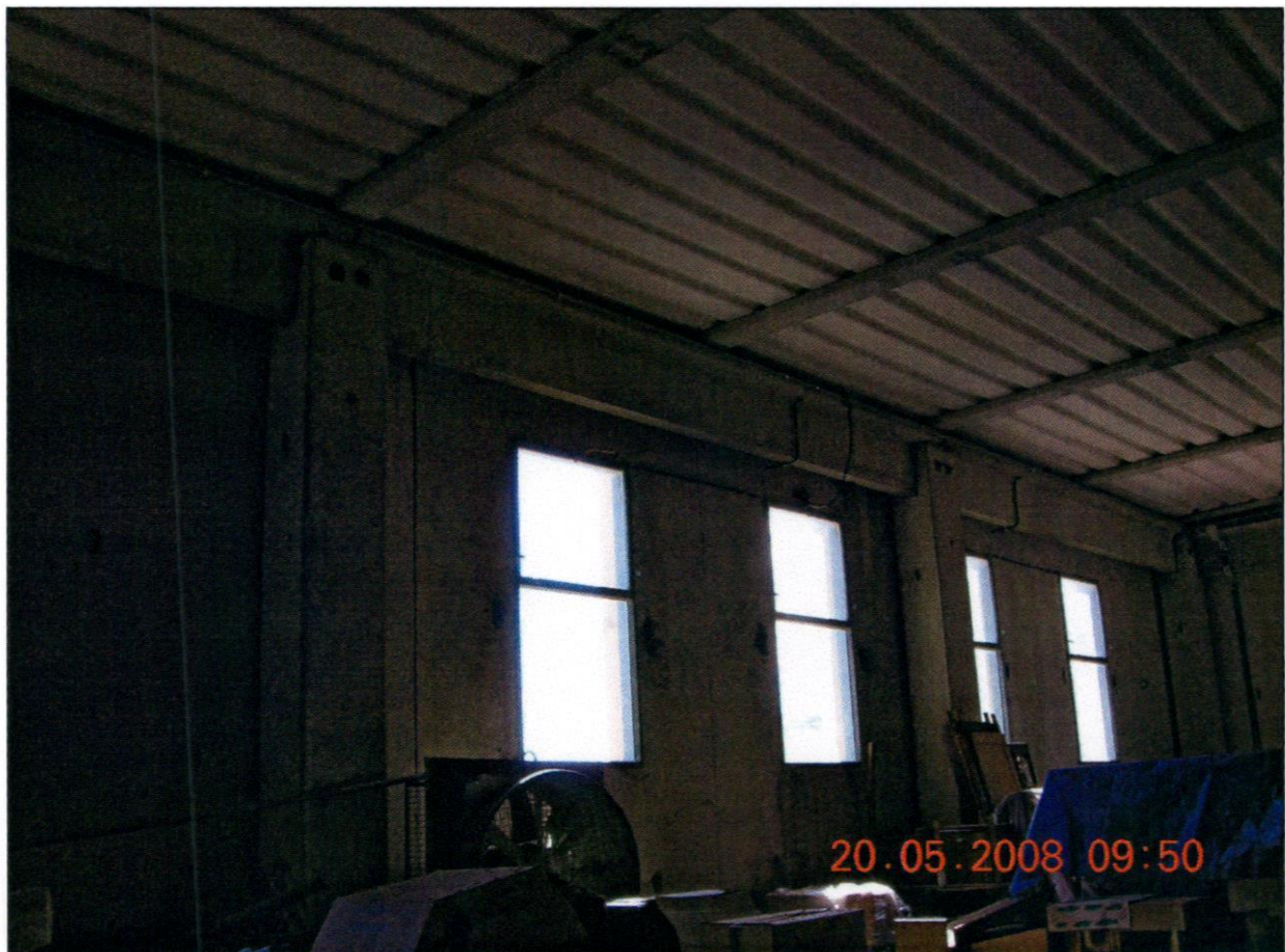
FOTO 12 - LA STRUTTURA È REALIZZATA INTERAMENTE CON ELEMENTI PREFABBRICATI.
