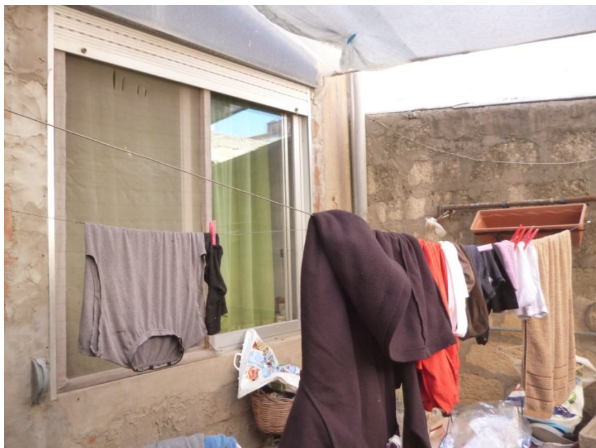
Foto n. 2: prospetto cortile interno
