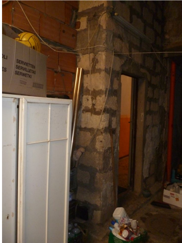
Foto n. 2: accesso al garage dall'interno
