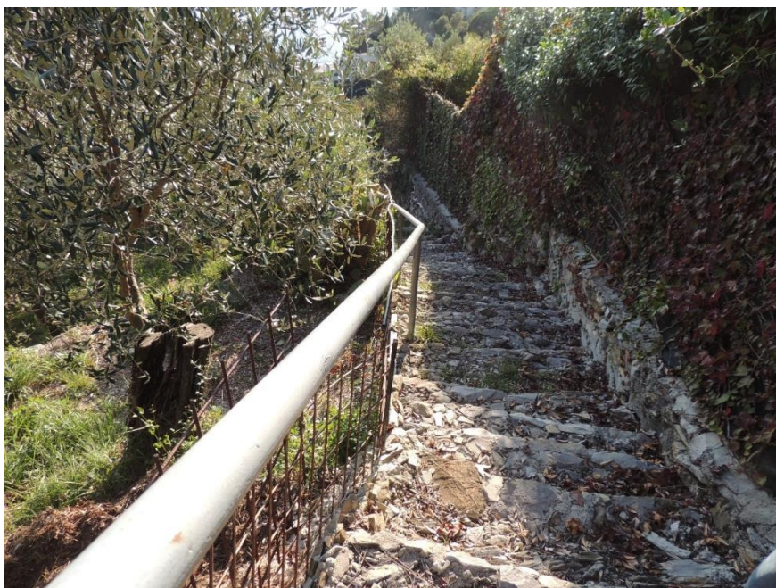
Foto n 4 Via Crosin del Diavolo, strada vicinale costituita da una scalinata ripida in pietra (tipica creuza ligure).
