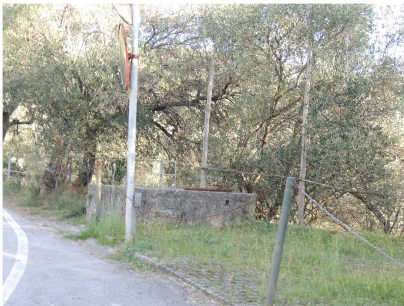
Foto n 1 Strada vicinale di accesso al terreno da Via Cornice di Sant'Ambrogio, Comune di Zoagli (Ge)
