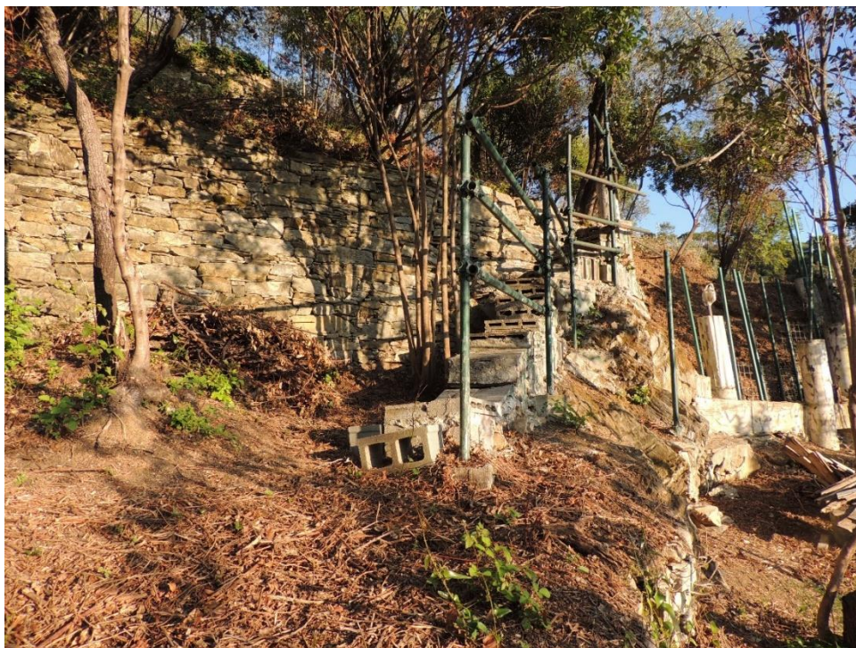
Foto n 17 scaletta di passaggio tra terrazzamenti della stessa proprietà
