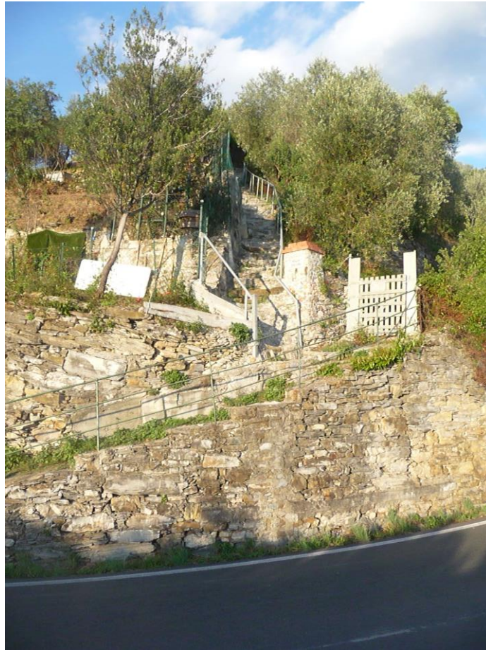
Foto n 9 vista su Via Crosin del Diavolo su Via Aurelia
