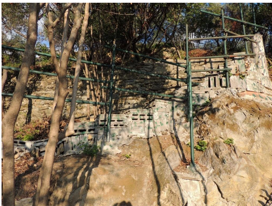
Foto n 16 scaletta di passaggio tra terrazzamenti della stessa proprietà
