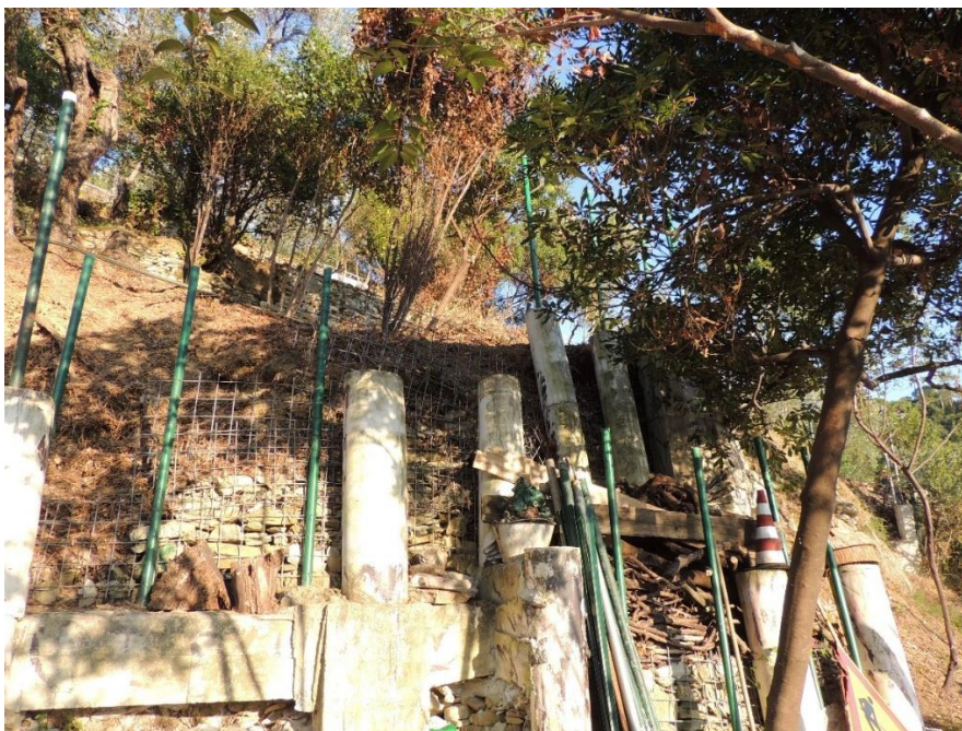
Foto n 15 rinforzo di contenimento provvisorio.
