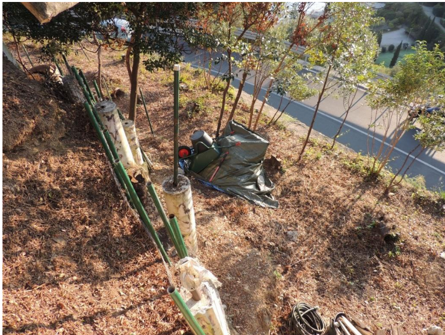
Foto n 22 vista su Via Aurelia
