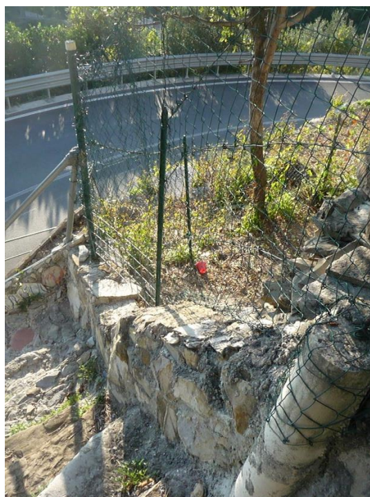
Foto n 6 vista su Via Crosin del Diavolo verso Via Aurelia: recinzione sulla strada vicinale costituita da una scalinata ripida in pietra (tipica creuza ligure).
