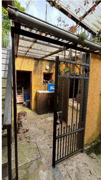
ripostiglio piano terra sotto terrazzo
