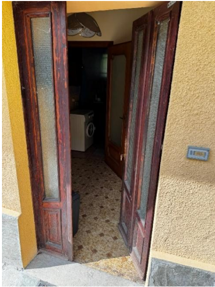
Ingresso piano primo
