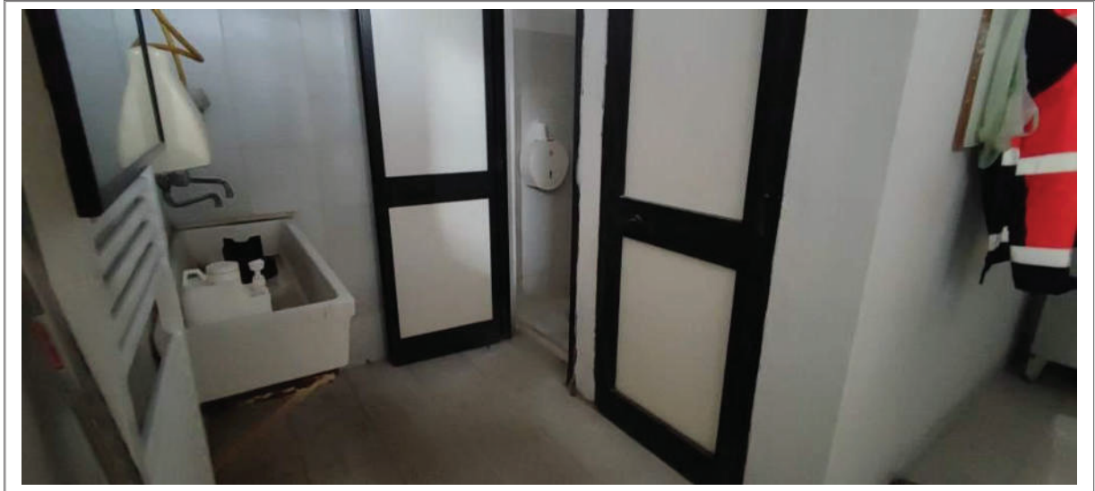
Foto n. 13 - Piano Terra – Bagni spogliatoi
