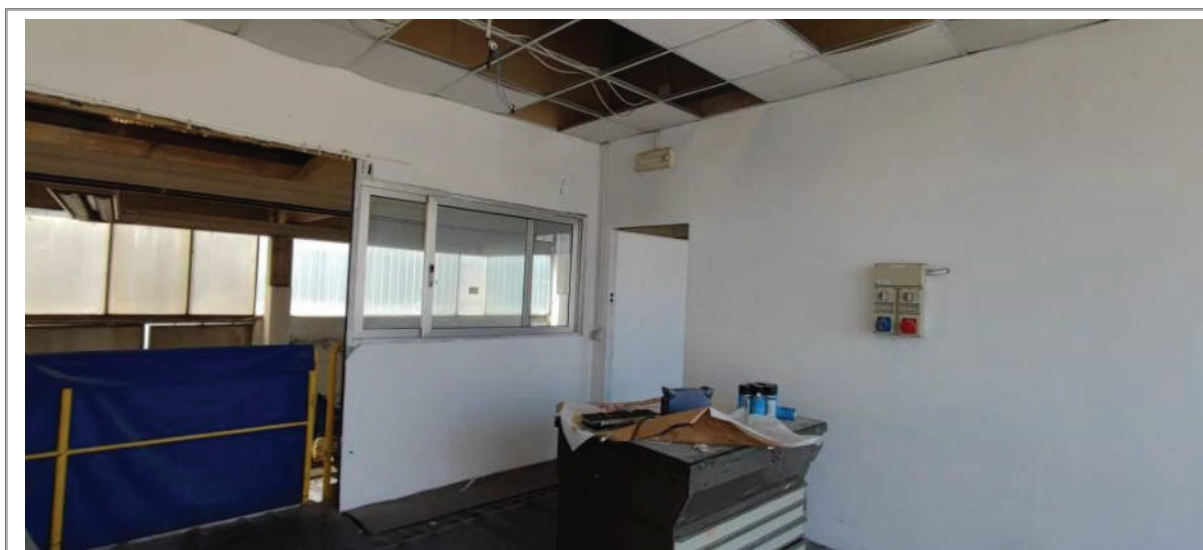
Foto n. 17 – Piano Primo – Vano sopra soppalco
