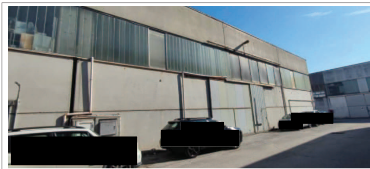
Foto n. 3 – Vista del capannone – Facciata SUD/OVEST
