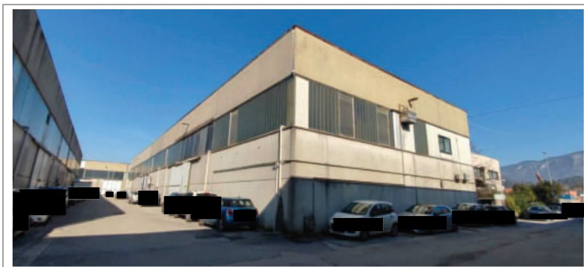
Foto n. 2 - Vista del capannone – Angolo SUD
