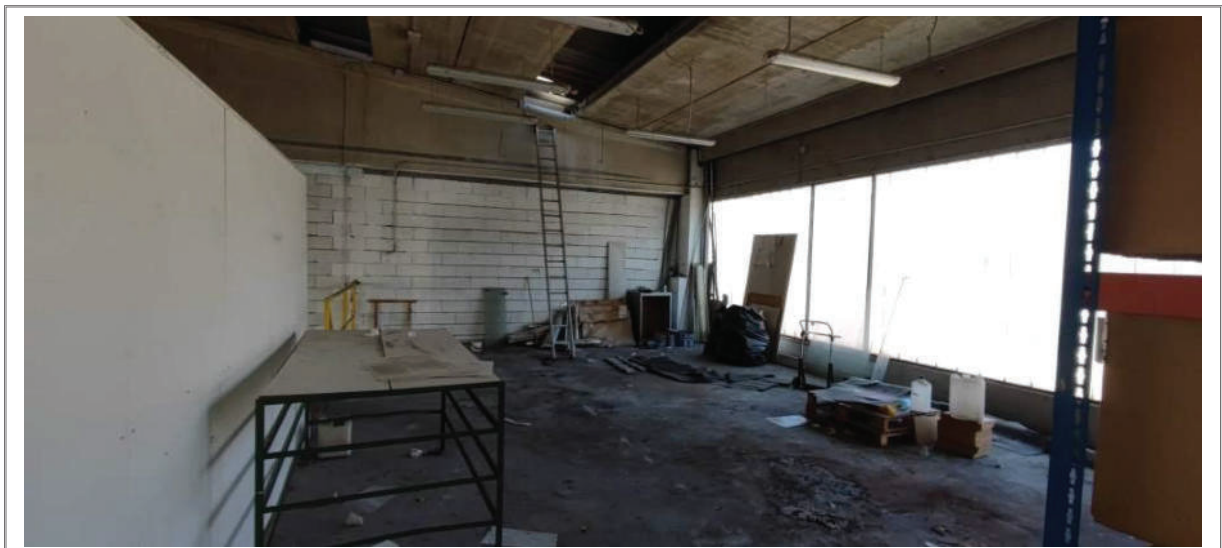
Foto n. 15 – Piano Primo - Soppalco
