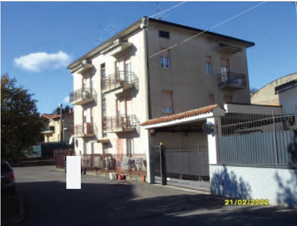
Fabbricato condominiale – Prospetto Sud Est
