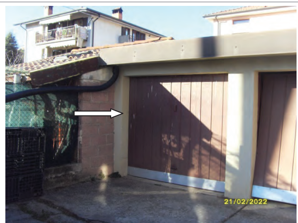
Autorimessa singola p.lla 1242 sub 2
