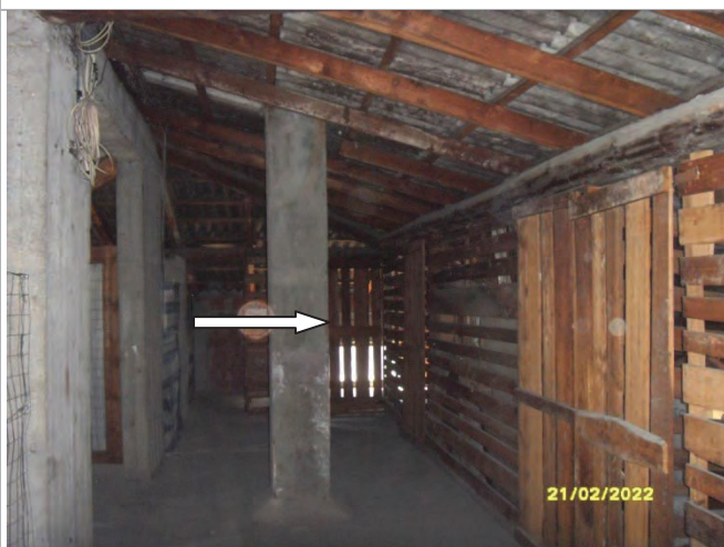
Porzione di sottotetto p.lla 1204 sub 709
