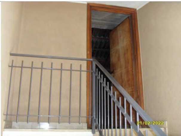
Accesso alla porzione di sottotetto
