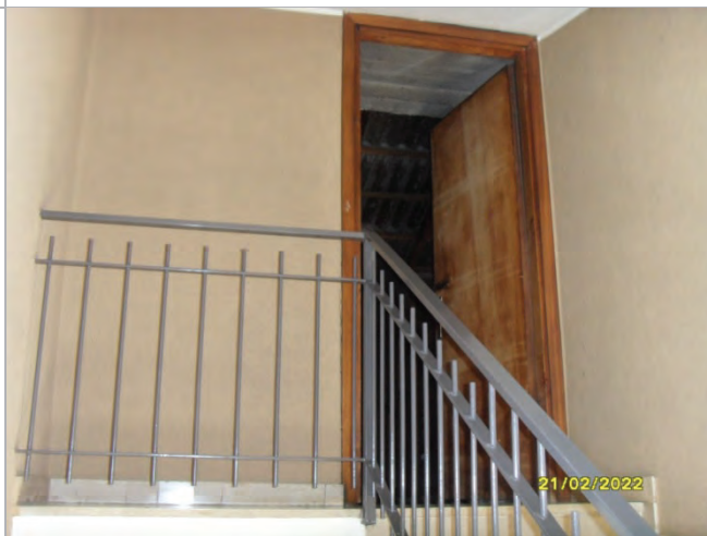
Accesso alla porzione di sottotetto
