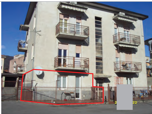
Prospetto Sud fabbricato condominiale
