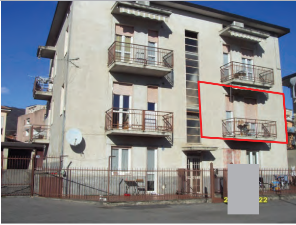
Prospetto Sud fabbricato condominiale
