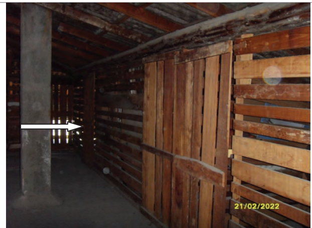
Porzione di sottotetto p.lla 1204 sub 710
