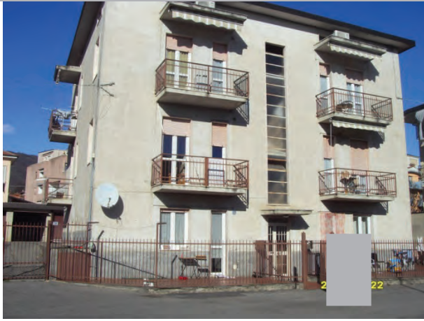
Prospetto Sud fabbricato condominiale
