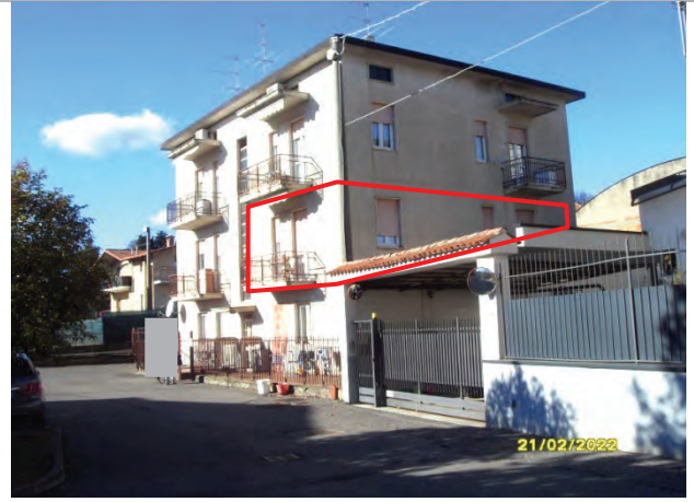
Prospetto Sud Est fabbricato condominiale
