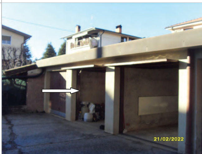
Autorimessa singola p.lla 1242 sub 3
