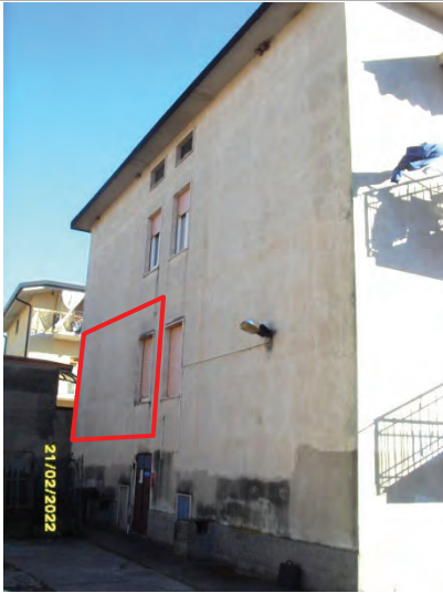
Fabbricato condominiale – Prospetto Nord
