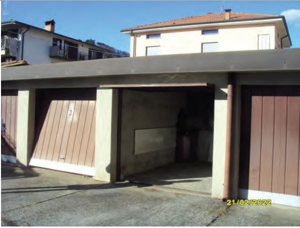
Autorimessa singola p.lla 1242 sub 4
