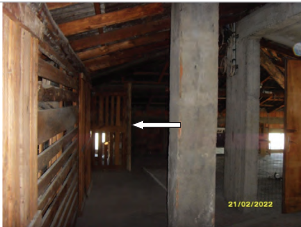
Porzione di sottotetto p.lla 1204 sub 712
