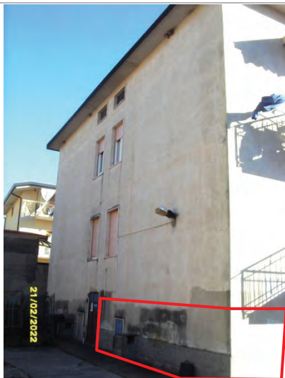
Fabbricato condominiale – Prospetto Nord Ovest
