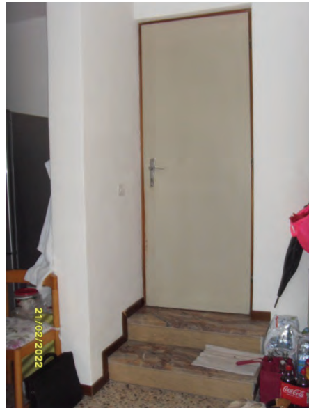
Ingresso locali p.lla 1204 sub 702
