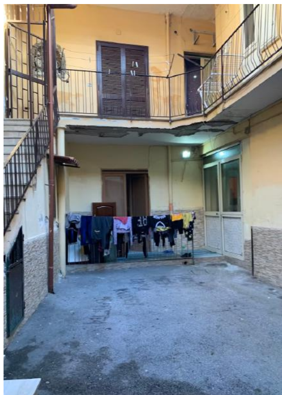
Foto n. 2 – prospetto porzione di fabbricato
