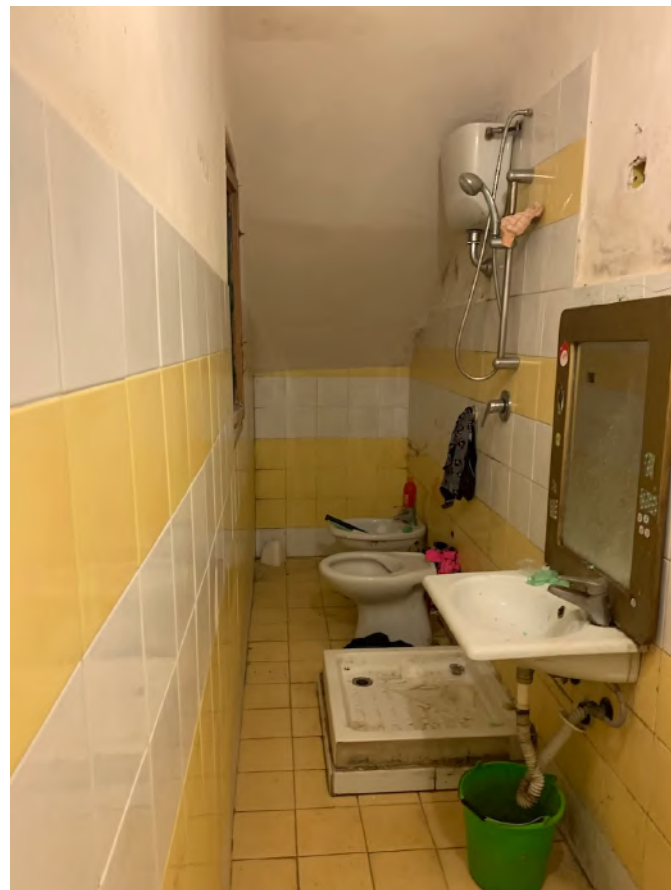
foto n.°6 – particolare bagno
