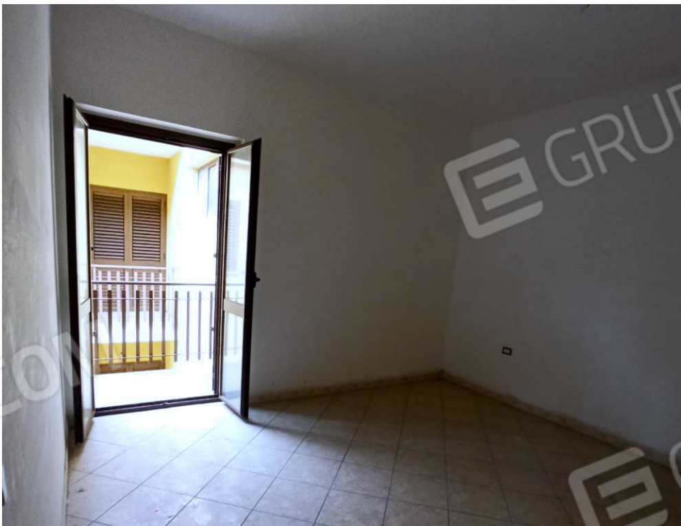
Foto n. 11: Ambiente adibito a camera da letto indicato con l'acronimo L2 16 nella planimetria allegata dell'unità abitativa censita in catasto fabbricati del comune di Nocera Terinese al foglio di mappa 45 , particella 422 , sub 16 .
