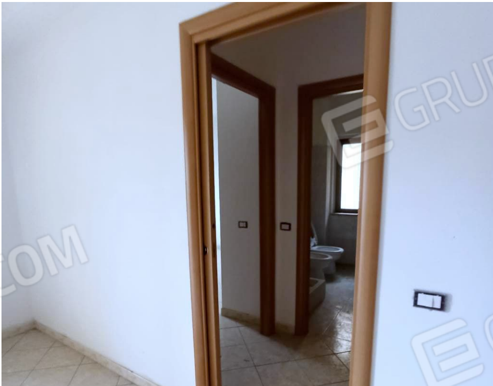
Foto n. 5: Ambiente adibito a disimpegno indicato con l'acronimo dis 16 nella planimetria allegata dell'unità abitativa censita in catasto fabbricati del comune di Nocera Terinese al foglio di mappa 45, particella 422, sub 16.
