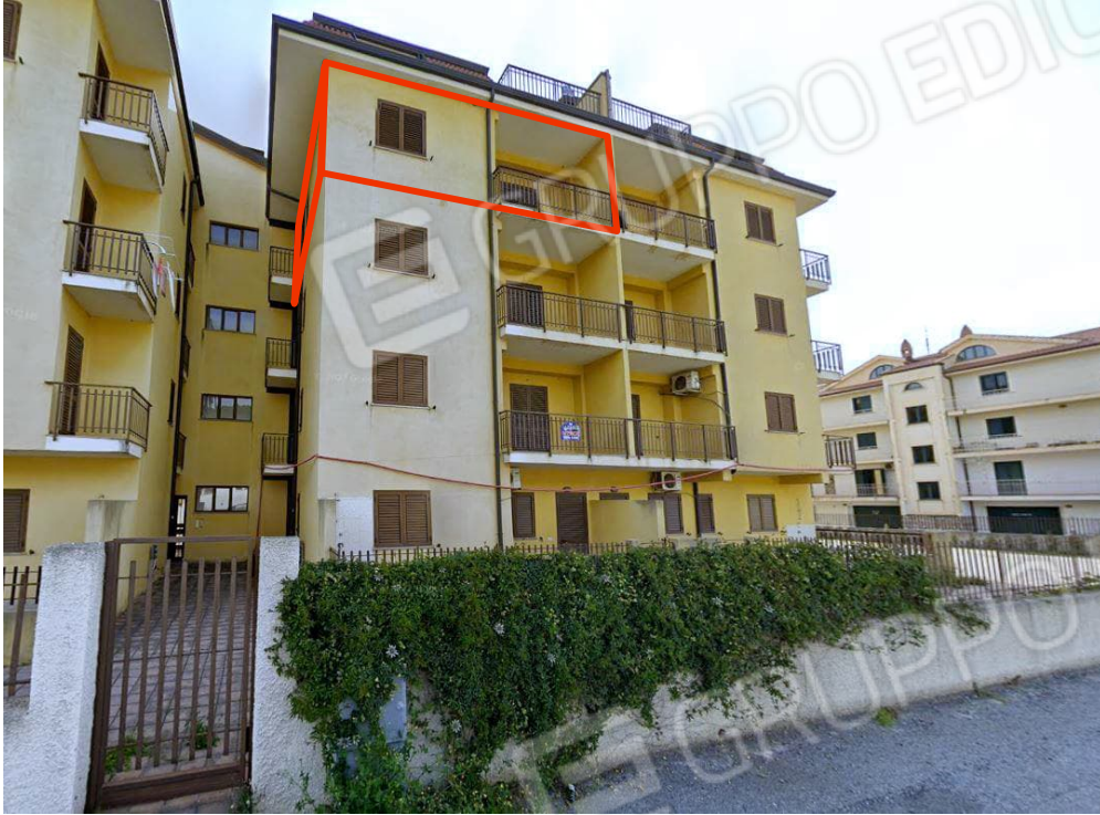
Appendice III: Foto panoramica con individuazione dell'unità immobiliare (lotto n. 2).
