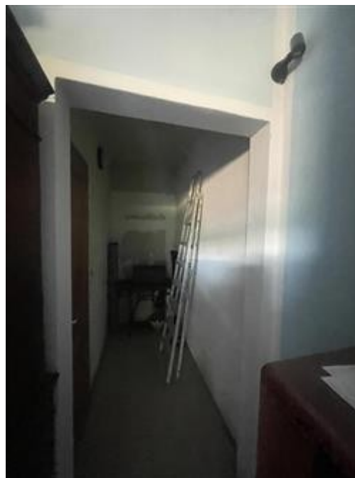
Il disimpegno con la porta del bagno a sinistra (sullo sfondo si nota ancora la chiusura della porta originale)
