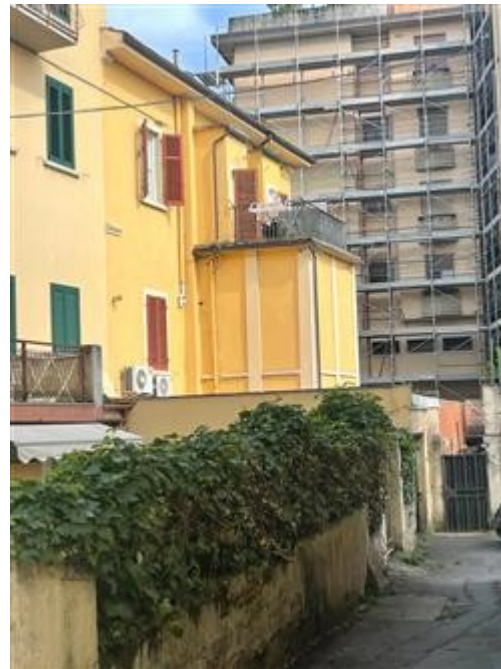
la parte sul retro del fabbricato in oggetto
