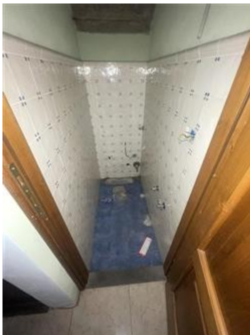
Il bagno ricavato nel sottoscala (ora privo dei sanitari)
