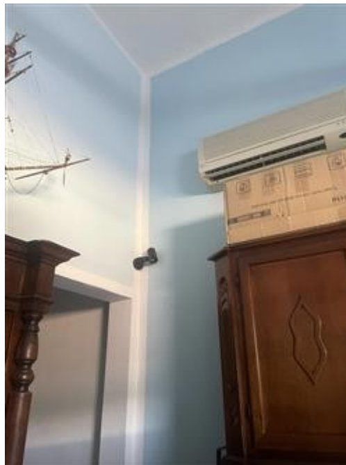
unico split esistente per la climatizzazione
