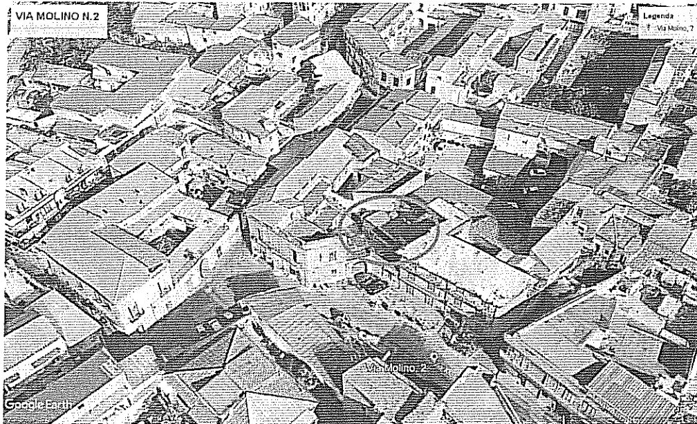
Figura 2: individuazione del LOTTO n.2. L'immobile affaccia all'interno del cortile a cui si accede dalla piazzetta generata dall'incrocio tra Via Molino e Via Roma.
