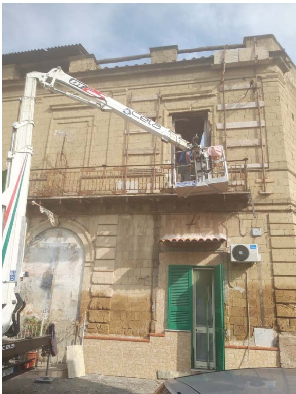
Impacchettamento della porzione di facciata a margine dell'area di solaio crollata
