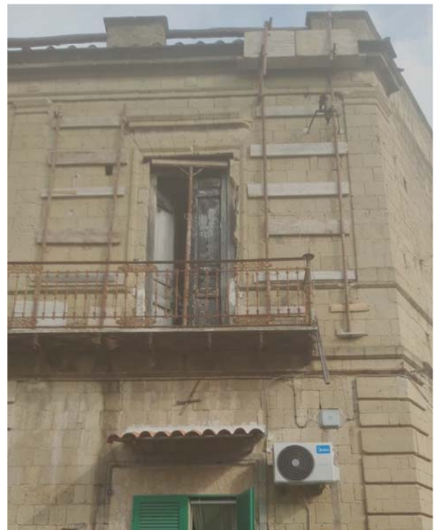
Impacchettamento della porzione di facciata a margine dell'area di solaio crollata
