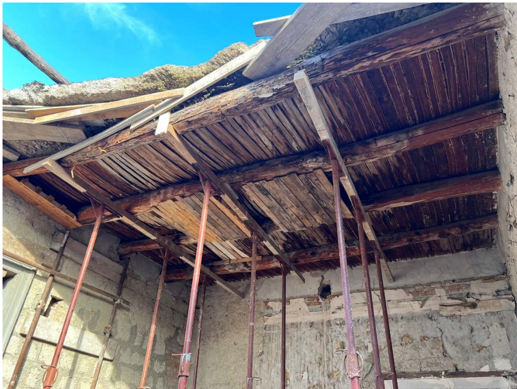
Puntellatura del campo di solaio ligneo non crollato
