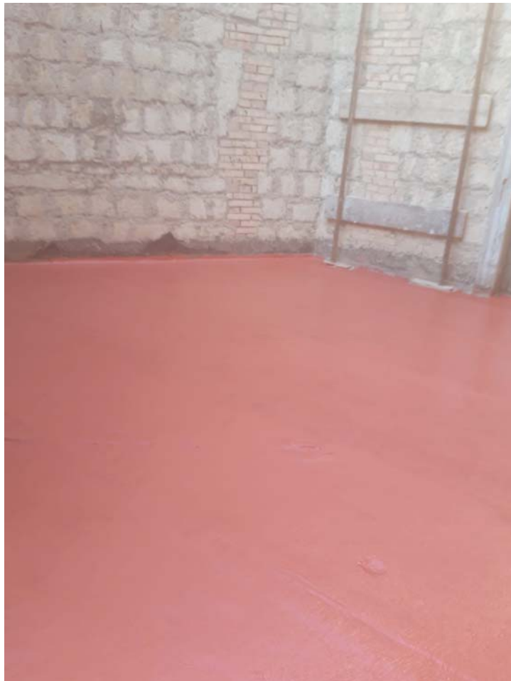
Impermeabilizzazione dell'ambiente rimasto parzialmente privo di copertura
