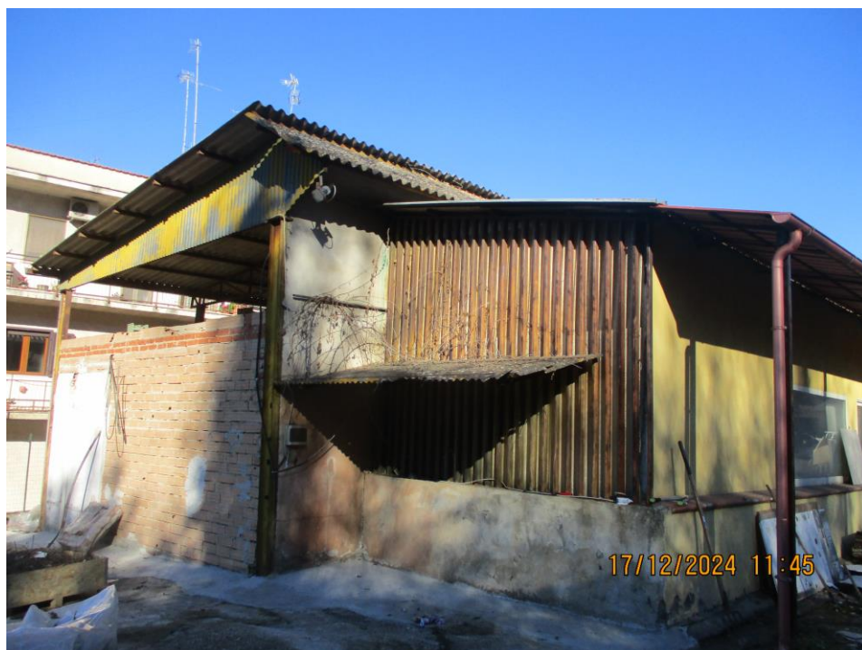
Vista esterna dei manufatti "posticci", irregolari da rimuovere
