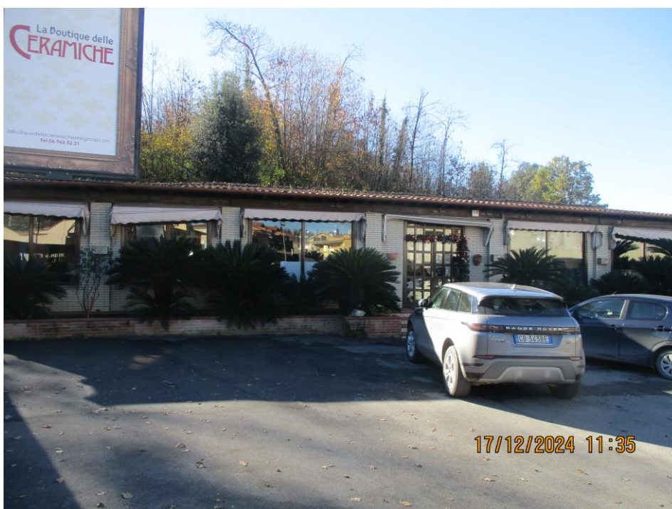
Vista esterna d'insieme dell'immobile di "minor consistenza"
