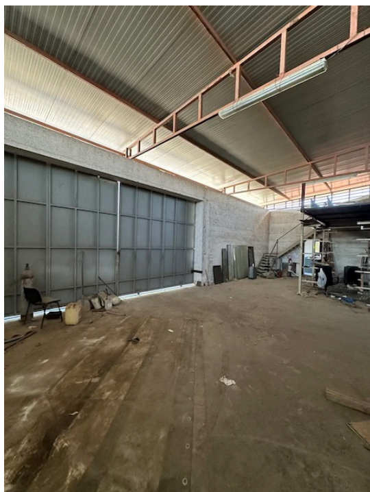
Foto n.2 – particolare area deposito
