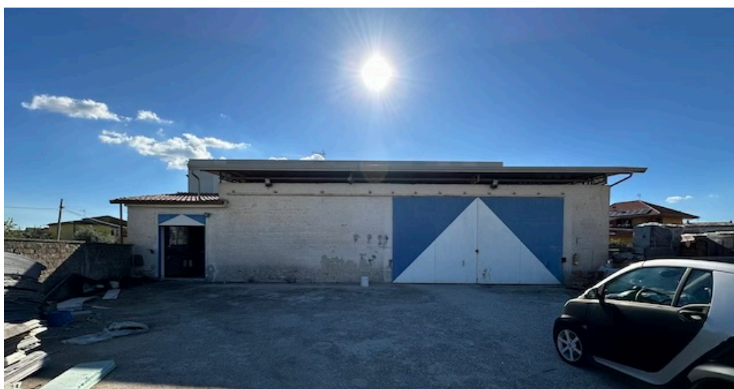
Foto n.1 – Prospetto fabbricato con corte scoperta
