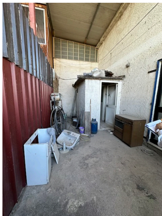
Foto n.5 – particolare corte coperta
