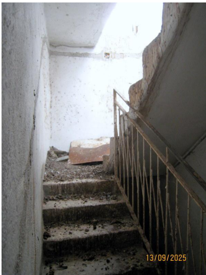
Foto n. 29. Scala che dal 2° piano porta al lastrico solare.
