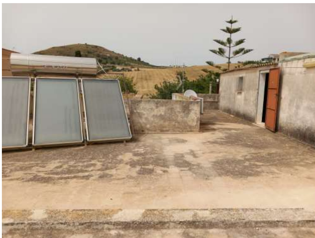
Foto n. 23 Altra vista della terrazza
