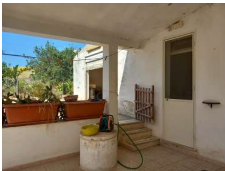
Foto n.18 vista accesso al ripostiglio dalla veranda coperta
