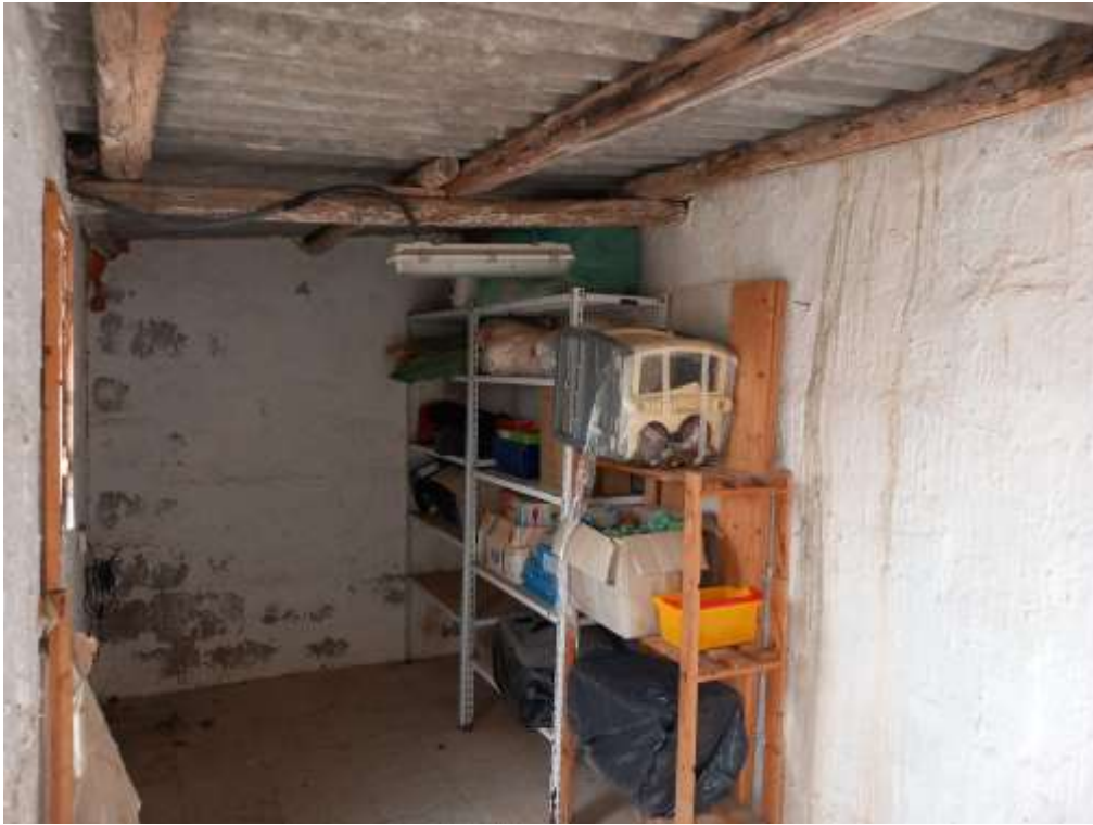
Foto n. 24 Vista del locale deposito
