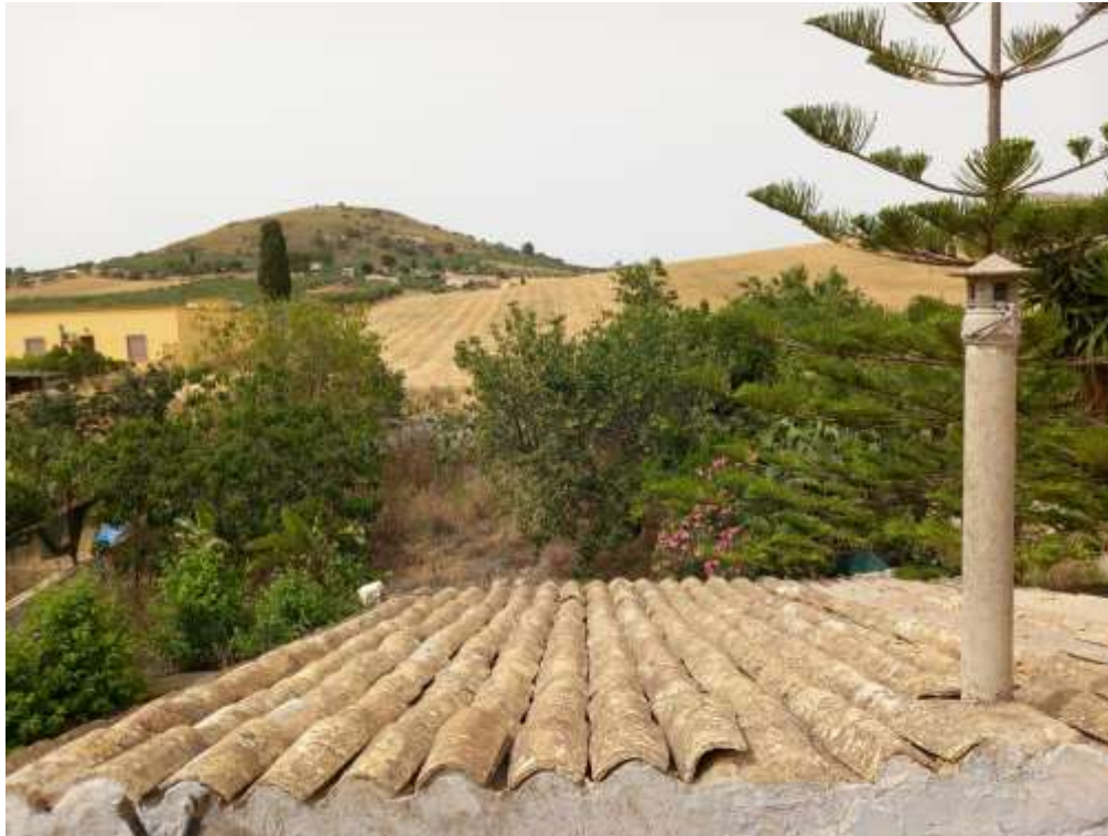
Foto n. 5 Vista tetto garage e appezzamento di terreno retrostante
