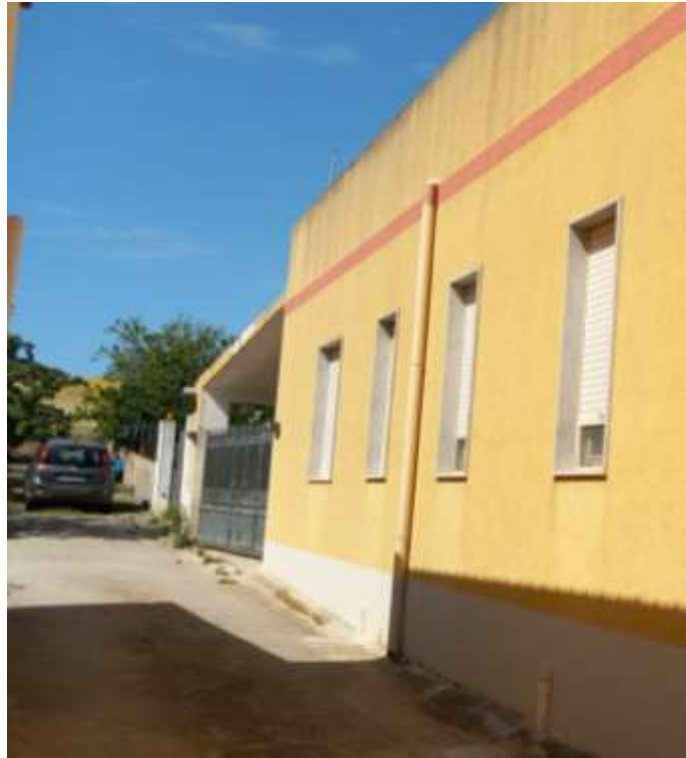
Foto n. 1 Vista della stradella di accesso al garage
