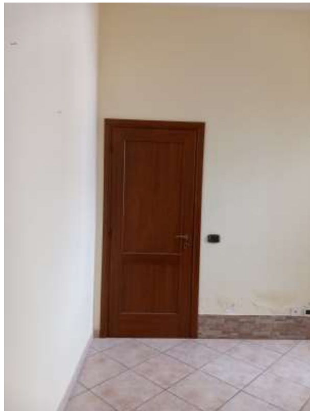
Foto n. 9 Vista porta realizzata sul poro portante
