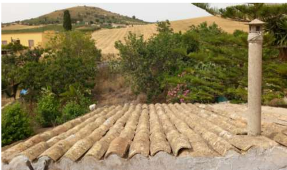
Foto n. 27 Vista della copertura del riposto
