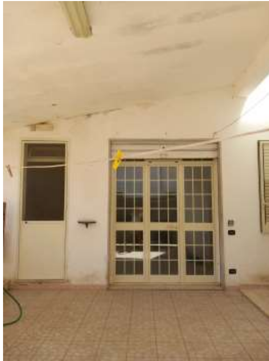
Foto n.16 Vista della veranda coperta
