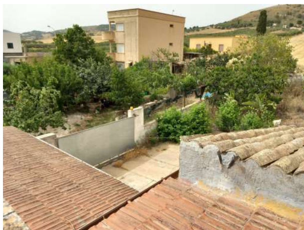
Foto n. 26 Vista della copertura della veranda
