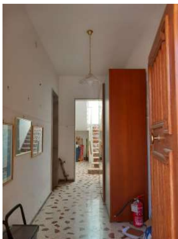
Foto n.5 Vista androne e corpo scala
