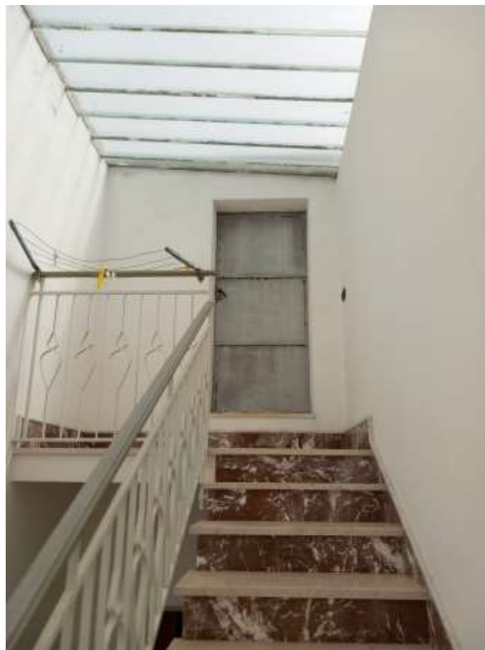
Foto n. 21 Vista del vano scala
