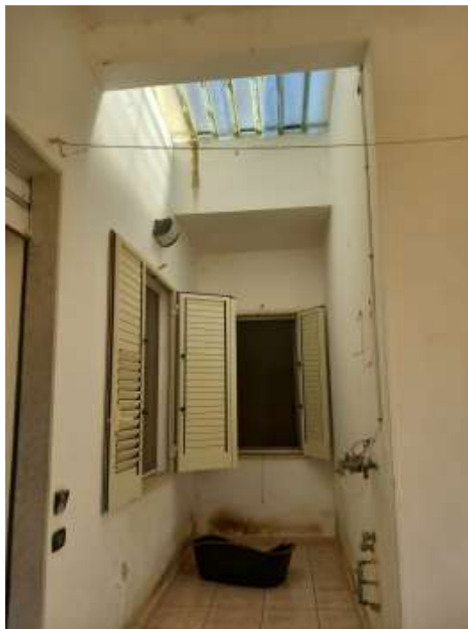
Foto n.17 Altra vista della veranda coperta
