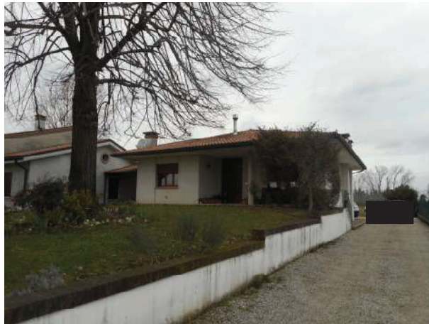
Foto 2 – particolare muro contenimento e vista frontale
