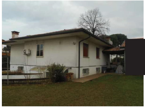
Foto 8 – posto auto coperto collegamento
