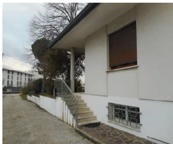
Foto 4 – scale accesso al porticato
