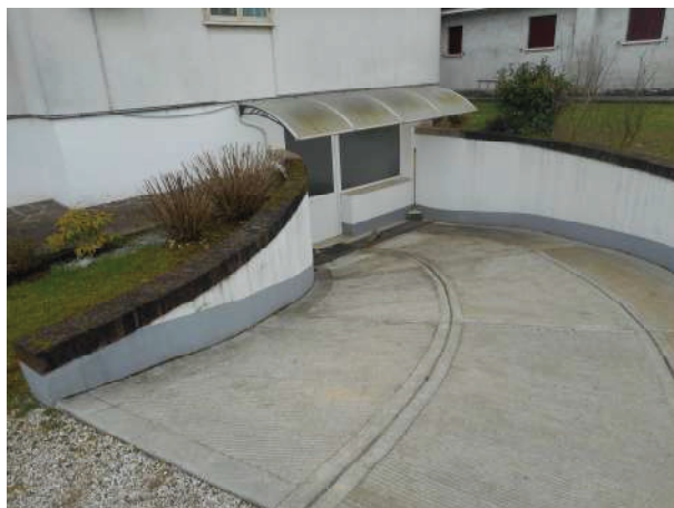
Foto 6 – rampa accesso al seminterrato
