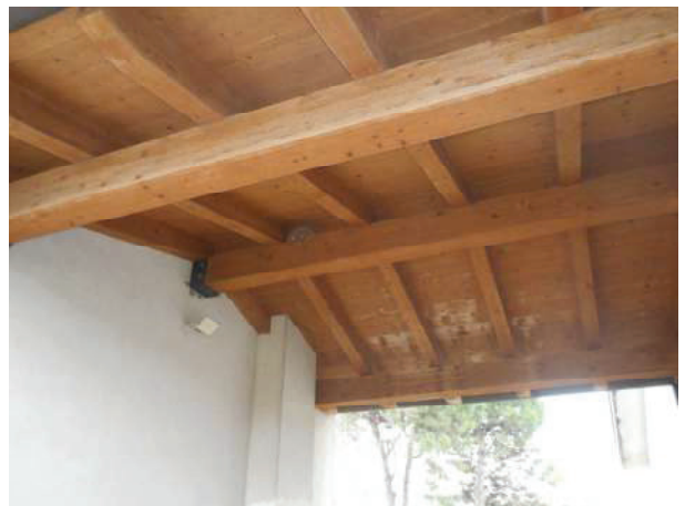
Foto 10 – particolare orditura tetto
