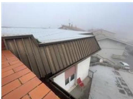
manto di copertura lastrico solare
