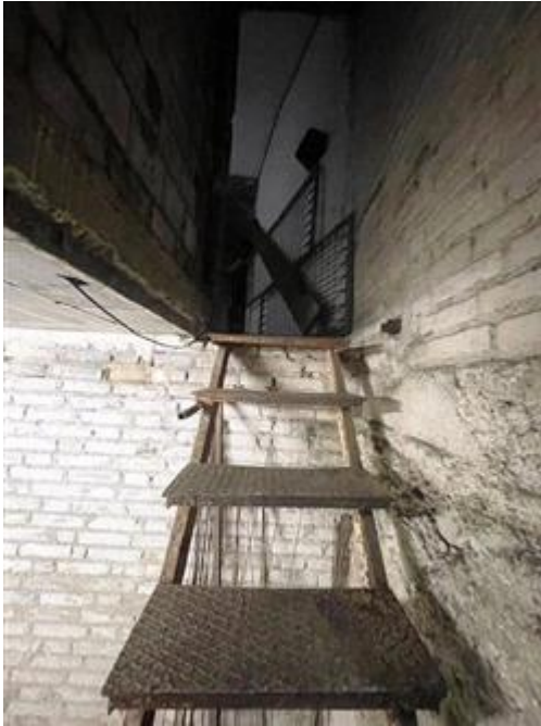
Scala di accesso al locale interrato
