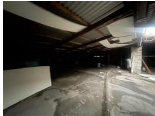
copertura del lastrico solare
