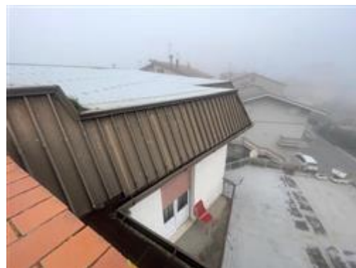
copertura del lastrico solare
