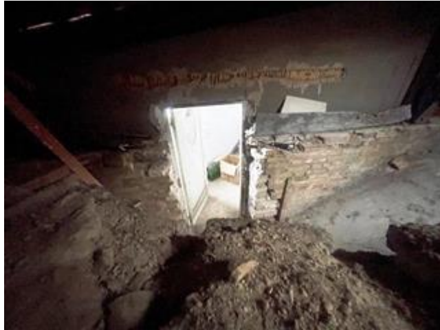
ingresso al lastrico solare coperto
