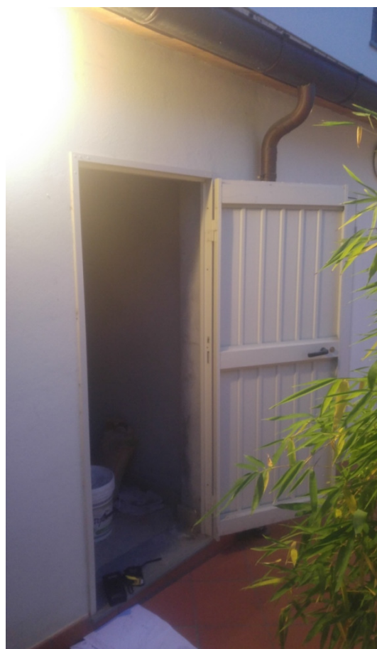
VISTA PORTA DI ACCESSO INTERNO SUB 33
