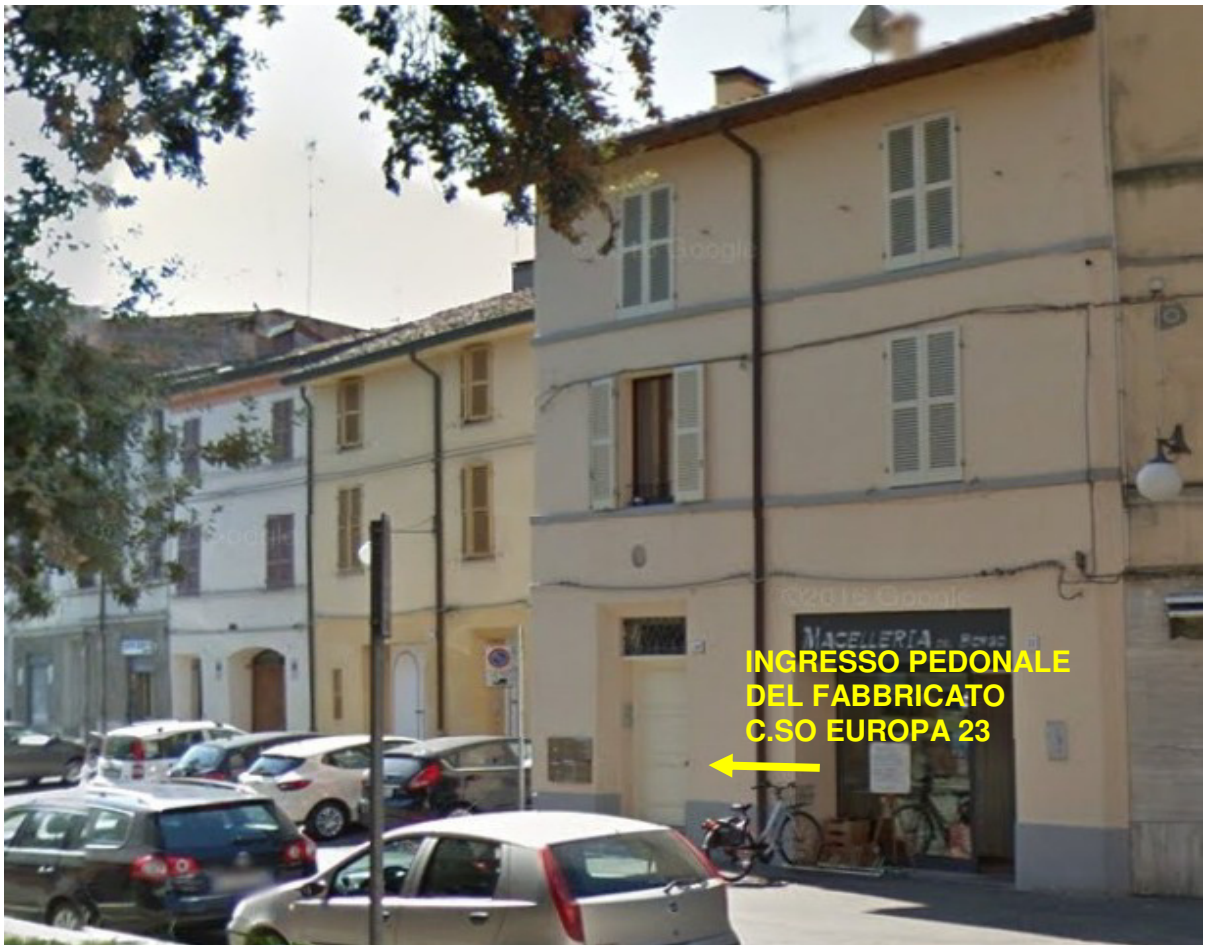
VISTA PROSPETTO NORD-EST DEL FABBRICATO – INGRESSO CORSO EUROPA 23
