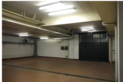
locale autorimessa al piano seminterrato
