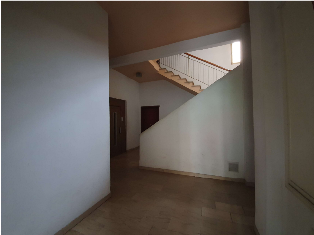
FOTO 03 – Ripresa fotografica delle scale condominiali
