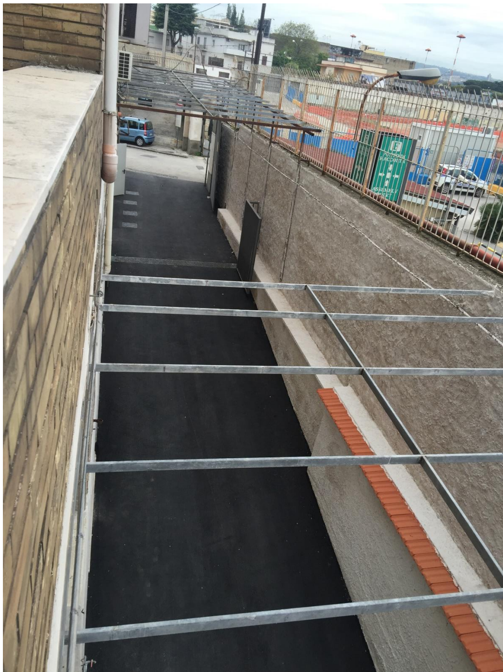
Foto n. 5 – rampa di ingresso al piano interrato
