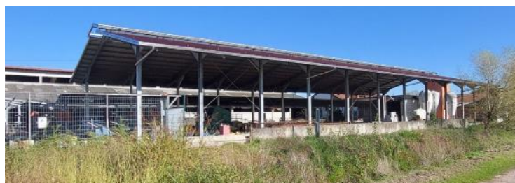
FOTO 98, 99 —Tettoia del 2008 mapp. 94 sub. 1
