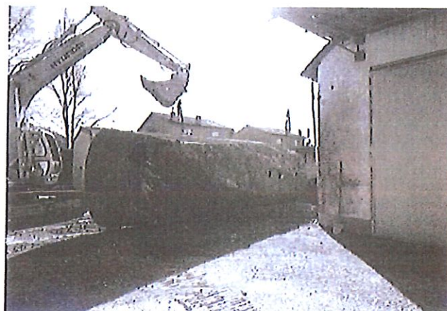
Rimozione cisterna n. 1
