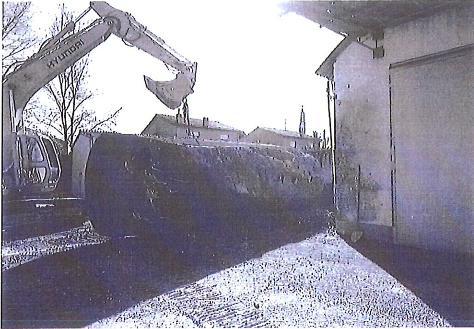
Rimozione cisterna n. 1
