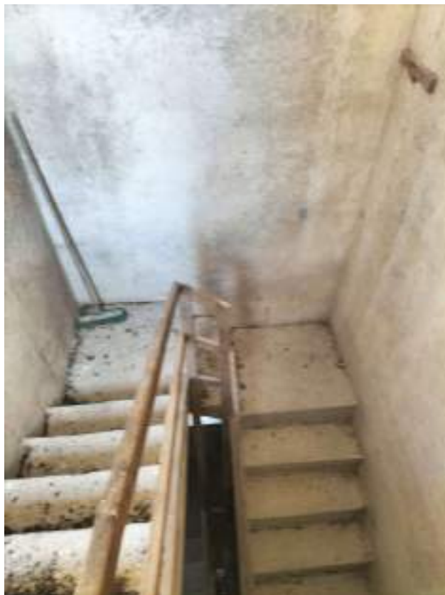
FOTO N.13 – Vista della scala interna di collegamento dell'immobile ancora al grezzo
