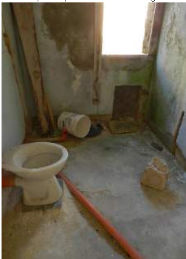
FOTO N.12 – Vista del vano wc ancora in fase di definizione al grezzo degli intonaci e senza infisso
