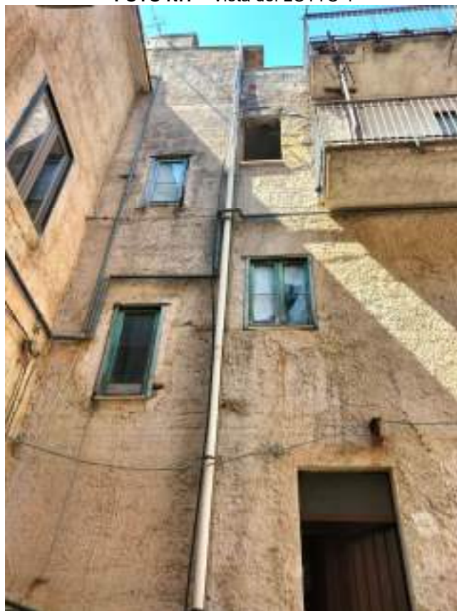
FOTO N.2 – Altra vista del prospetto principale del LOTTO 1
