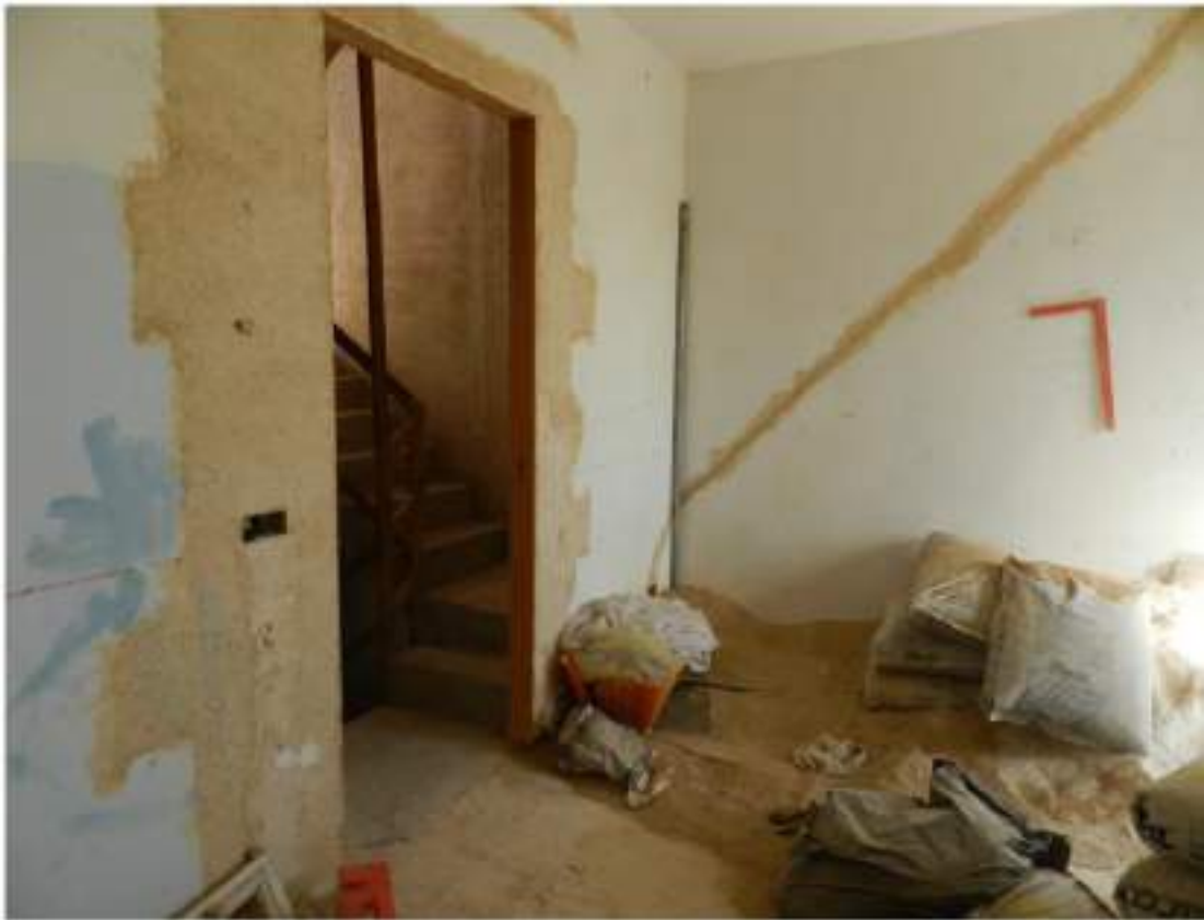
FOTO N.9 – Vista del vano posto al piano secondo del LOTTO 1 ancora in fase di ultimazione
