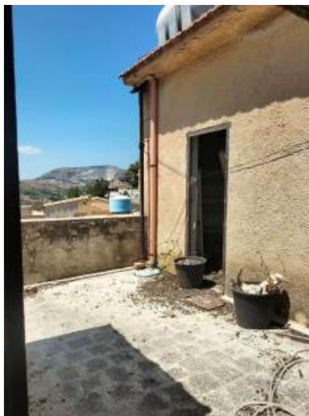
FOTO N.14 – Vista del locale di sgombero ubicato sul piano di copertura del LOTTO 1
