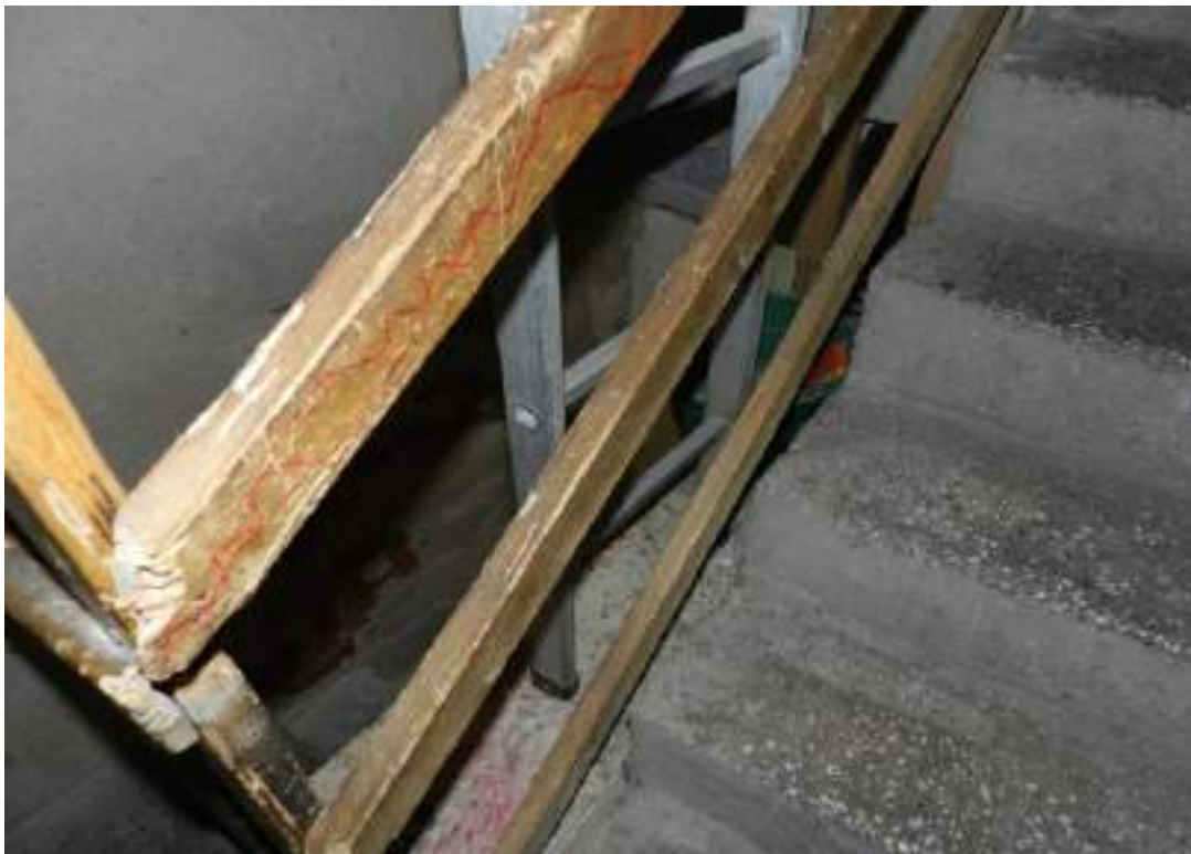
FOTO N.4 – Vista della scala interna di collegamento dell'immobile ancora al grezzo
