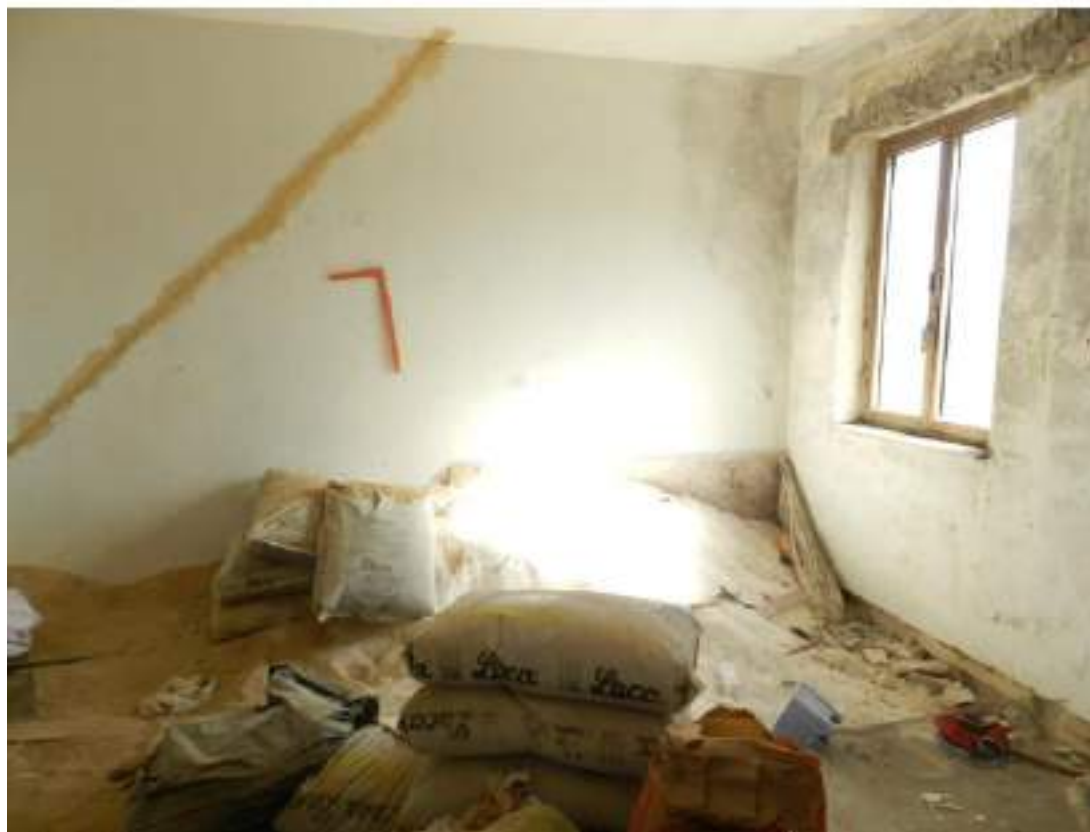
FOTO N.10 – Altra vista del vano posto al piano secondo del LOTTO 1 ancora in fase di ultimazione
