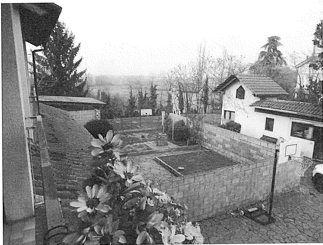
Porzione di terreno (identificata catastalmente come corte comune) definita da recinzione in blocchi di cls a delimitare giardino ad uso del fabbricato principale posto verso Nord
