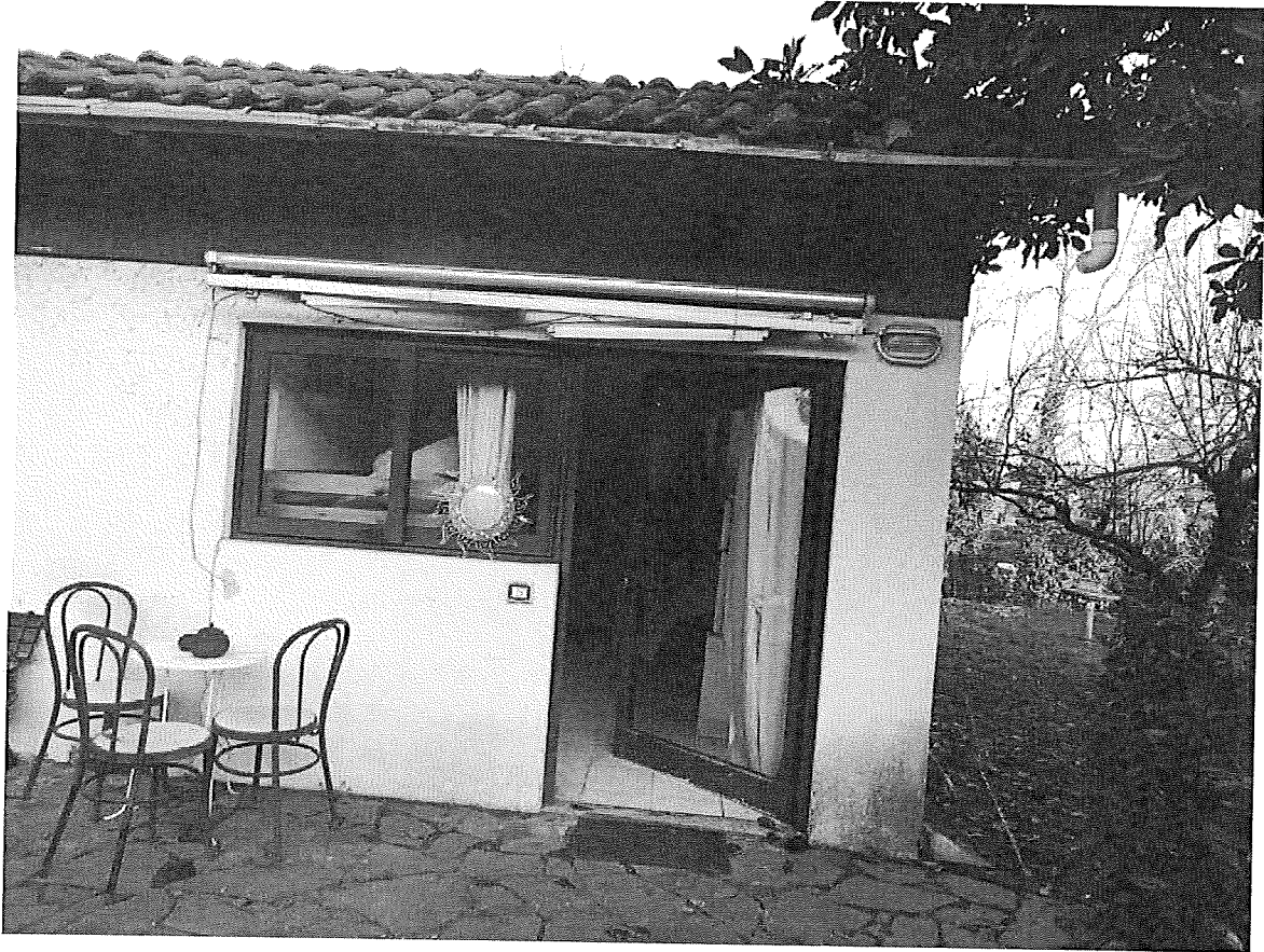
Piano terreno - Prospecto Ovest – ingresso al fabbricato
