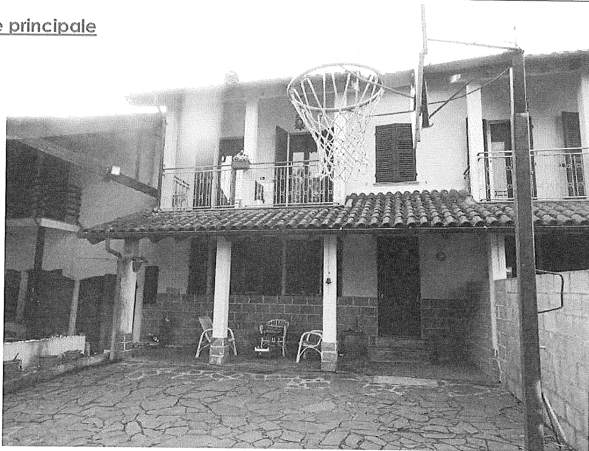
Prospetto Est – porzione di bene principale verso Sud
