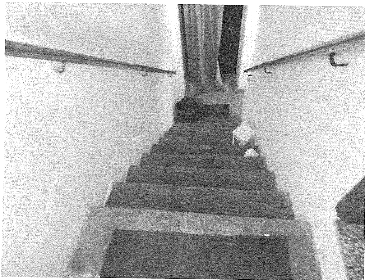
Scala di collegamento fra piano terra e piano primo
