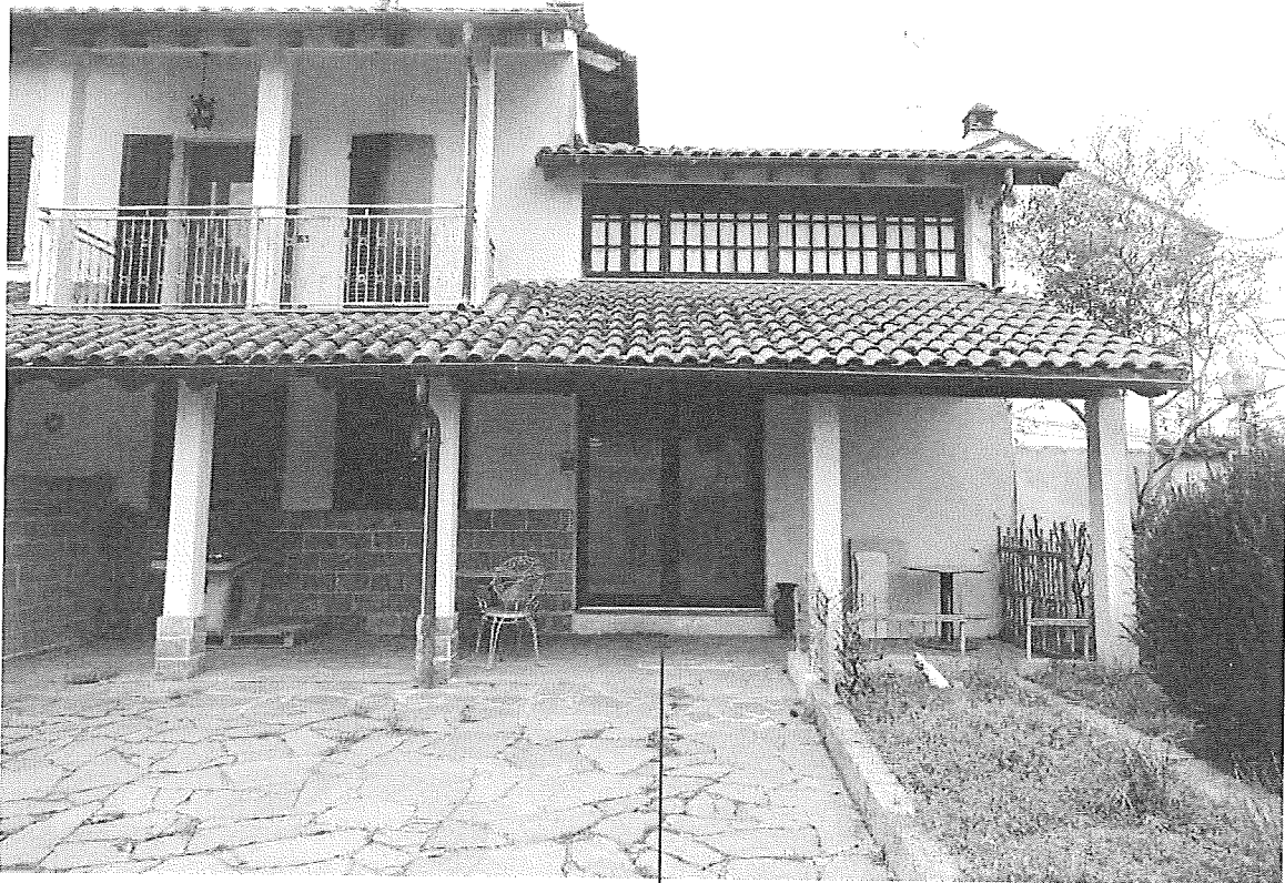
Prospetto Est – ingresso all'immobile
