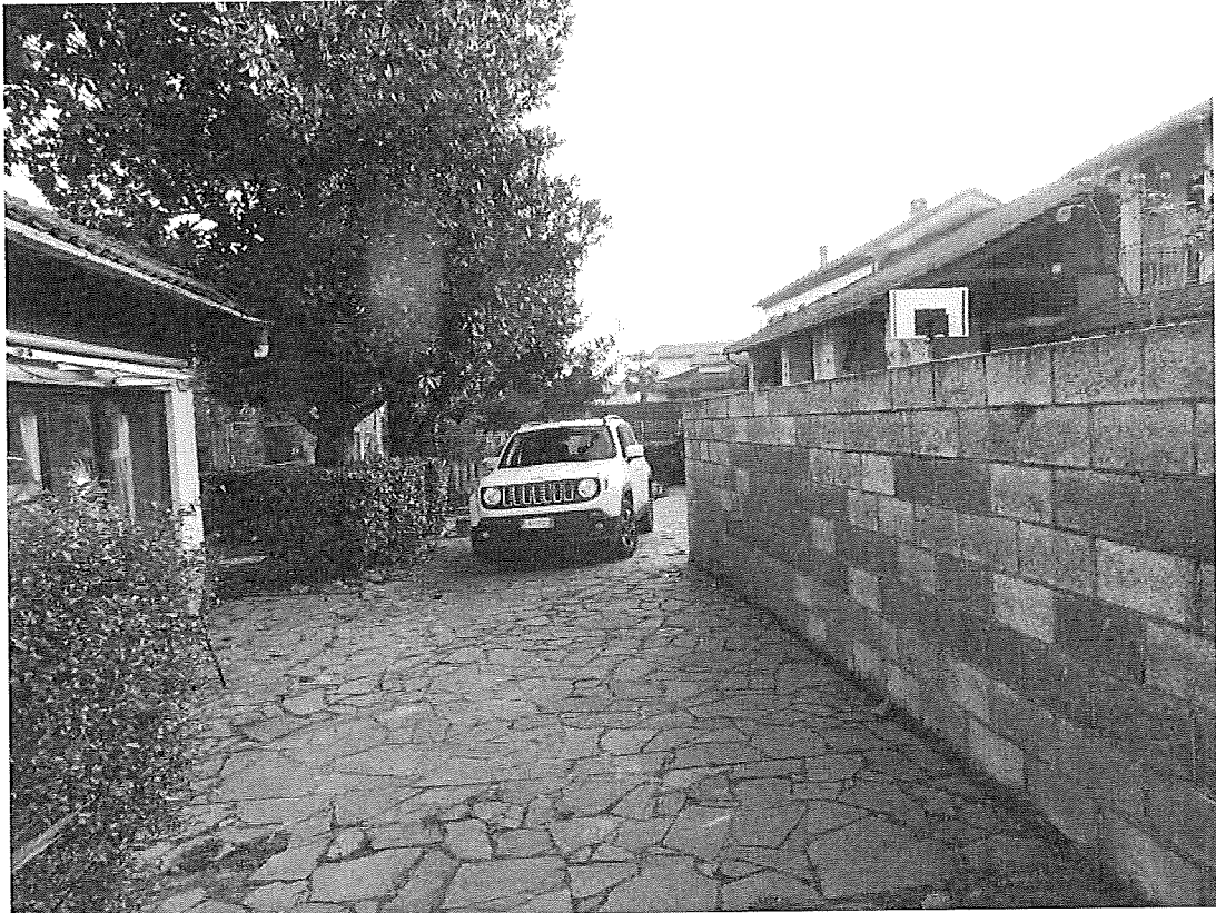
Corte comune che permette di raggiungere la porzione di bene principale posta verso Nord
