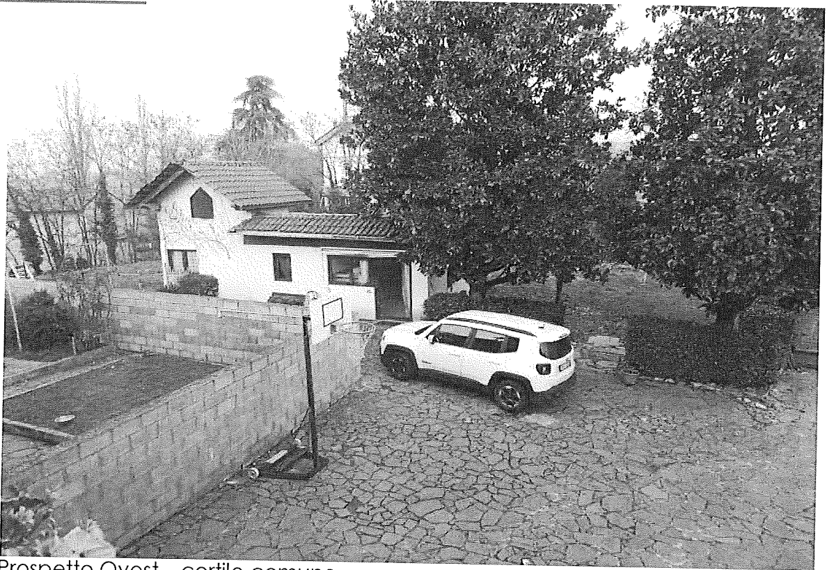
Prospetto Ovest – cortile comune
