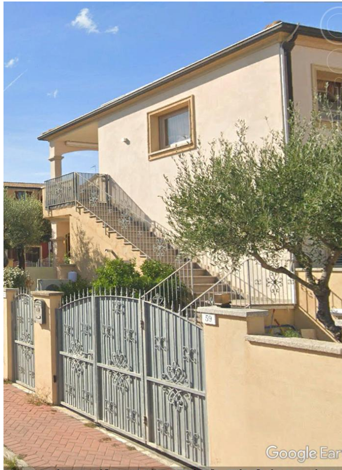
Vista da via della Stampa
