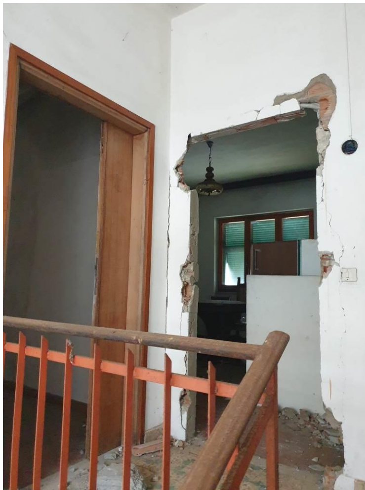
FOTO N.30 – vista apertura nuovo ingresso dal vano scale comune
