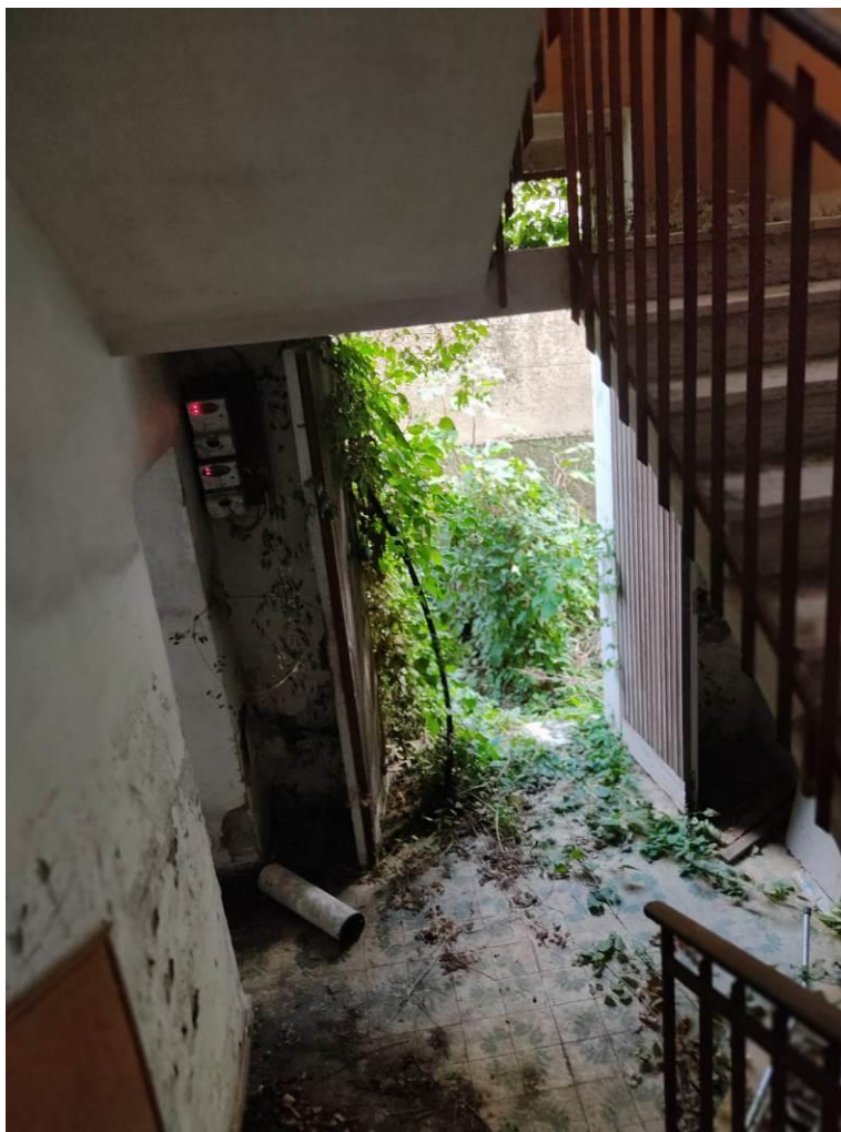
FOTO N.9 – Vista androne vano scala comune
