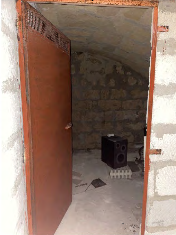
Foto 13: A2 Cantinola a piano Interrato- vista da ingresso
