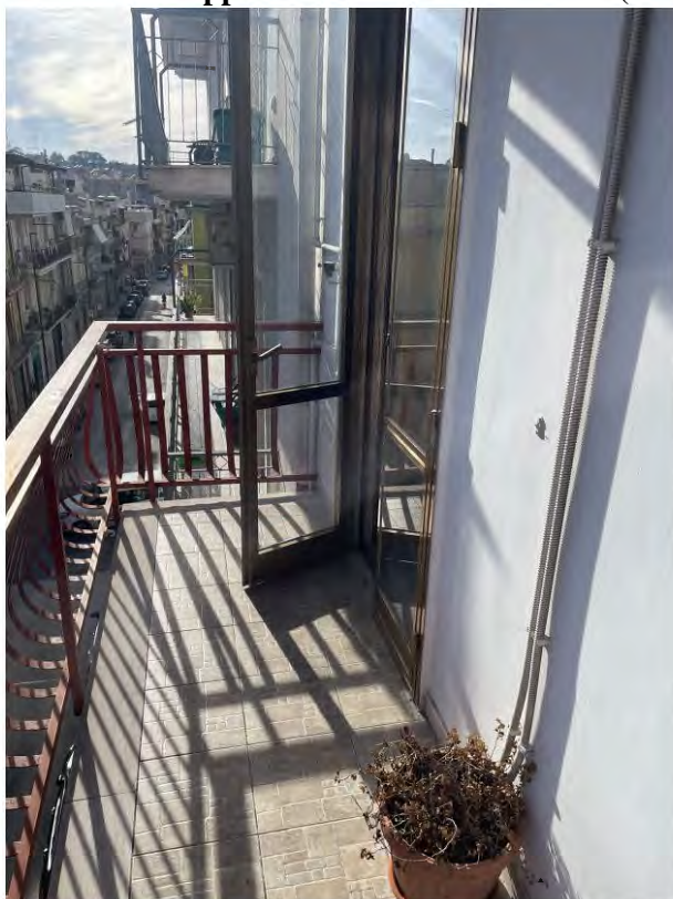
Foto 12: A1 Appartamento P.2° su rialzato (3° catastale) – Balcone Vista 2
