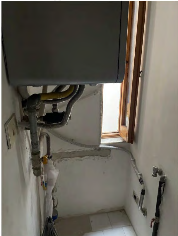
Foto 10: A1 Appartamento P.2° su rialzato (3° catastale) – Ripostiglio
