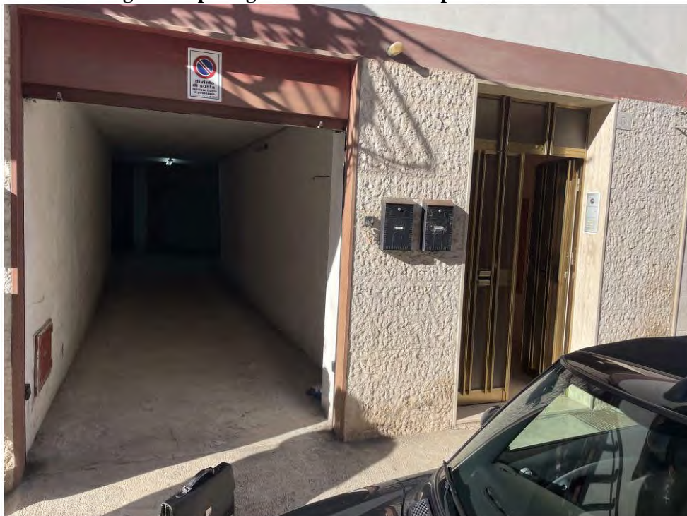
Foto 16: B Ingresso e passaggio comune rimessa a piano terra – civico 5/A
