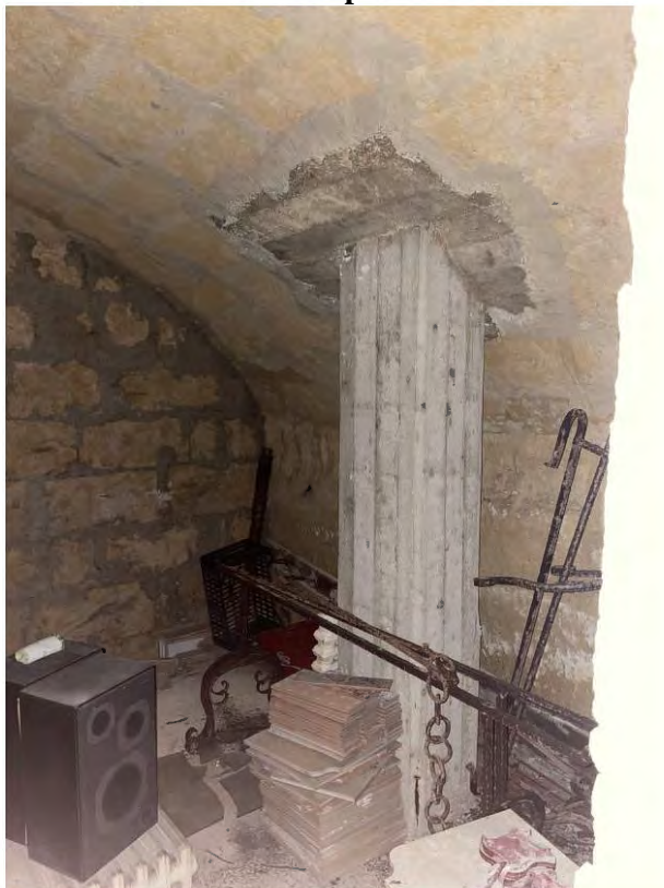
Foto 14: A2 Cantinola a piano Interrato- vista interna
