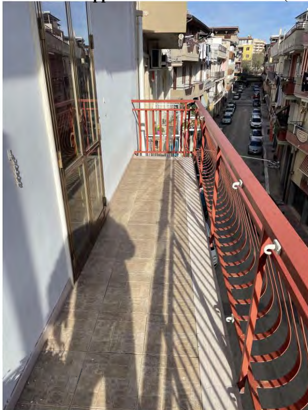
Foto 11: A1 Appartamento P.2° su rialzato (3° catastale) – Balcone Vista 1
