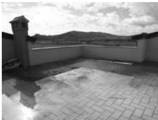
Immagini dell'allagamento dei terrazzi di copertura con infiltrazioni negli appartamenti del terzo livello
