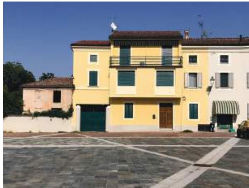
Prospetto sud-ovest fabbricato residenziale e fabbricato accessorio
