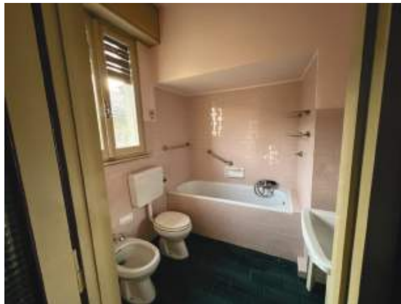
Bagno piano secondo (vista verso sud-est)
