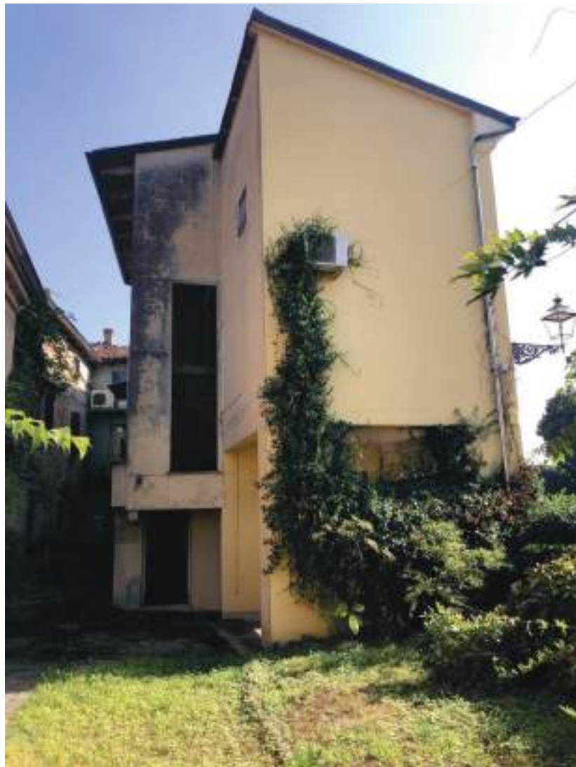
Prospetto nord-ovest fabbricato residenziale
