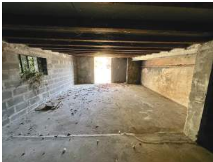
Particolare interno autorimessa da DEMOLIRE (vista verso esterno)
