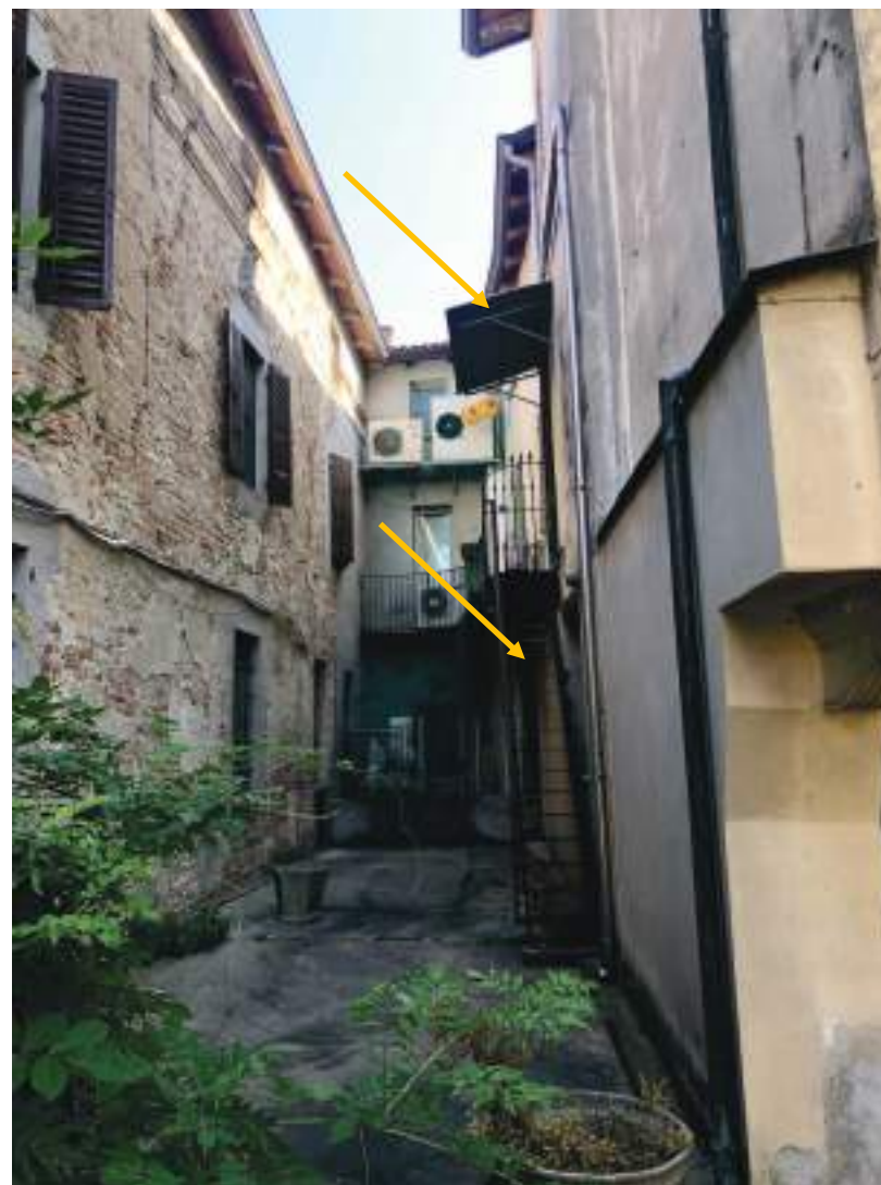
Particolare cortile interno: scala metallica e pensilina da rimuovere
