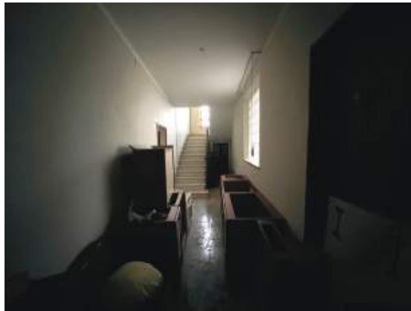
Vano scala piano terra (vista verso nord-ovest)
