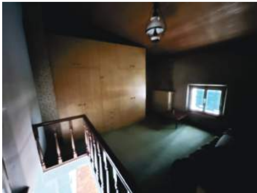
Locale soffitta a piano secondo (vista verso sud-est)
