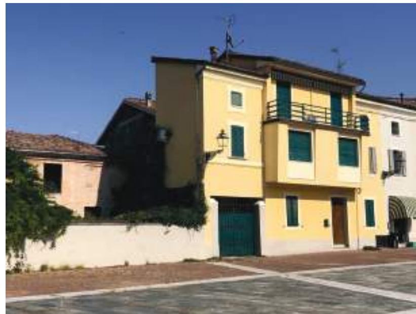
Prospetto ovest fabbricato residenziale
