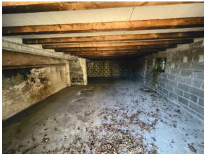
Particolare interno autorimessa da DEMOLIRE
