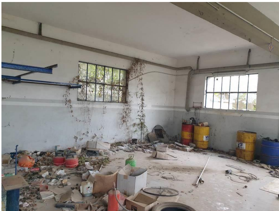
FOTO N.5 – Vista interna immobile ad uso officina
