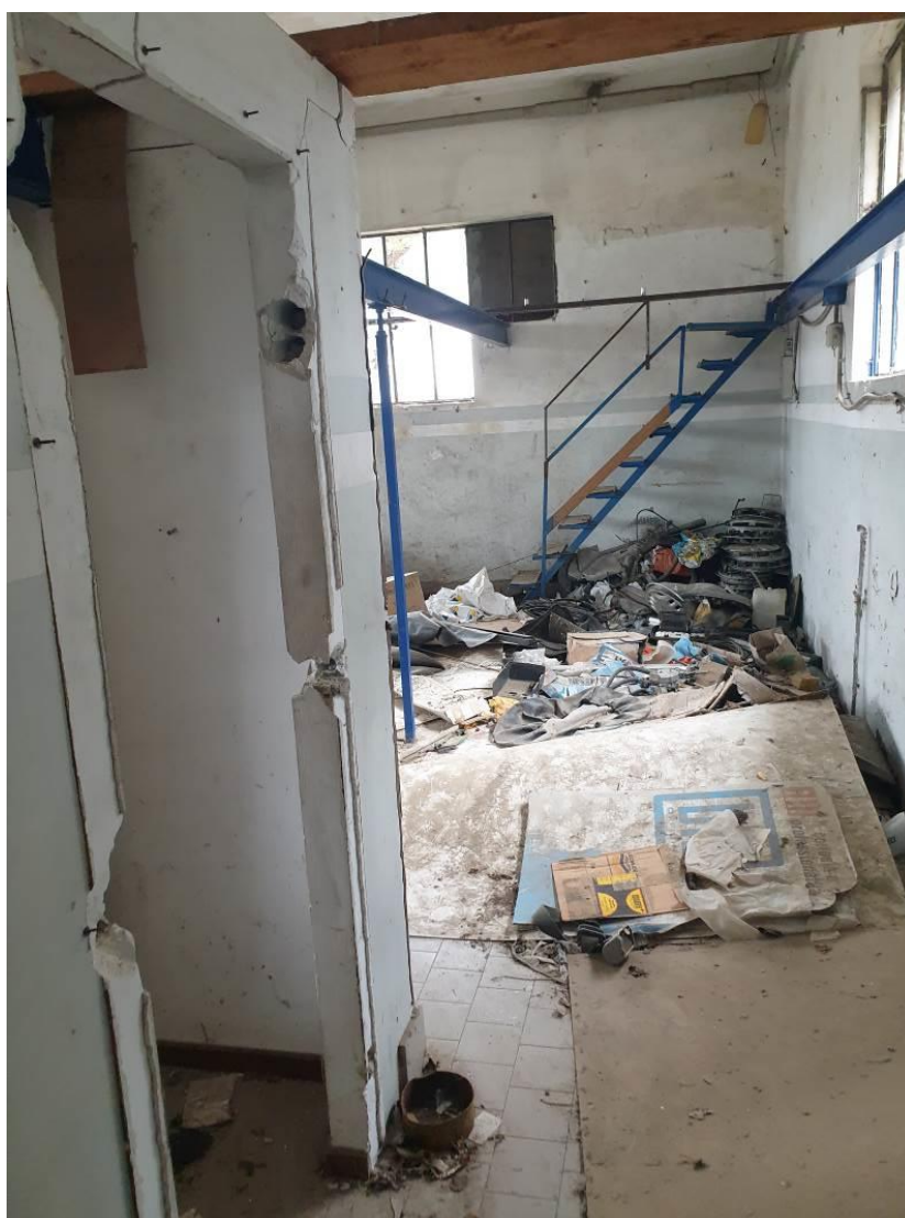
FOTO N.6 – Vista interna immobile ad uso officina
