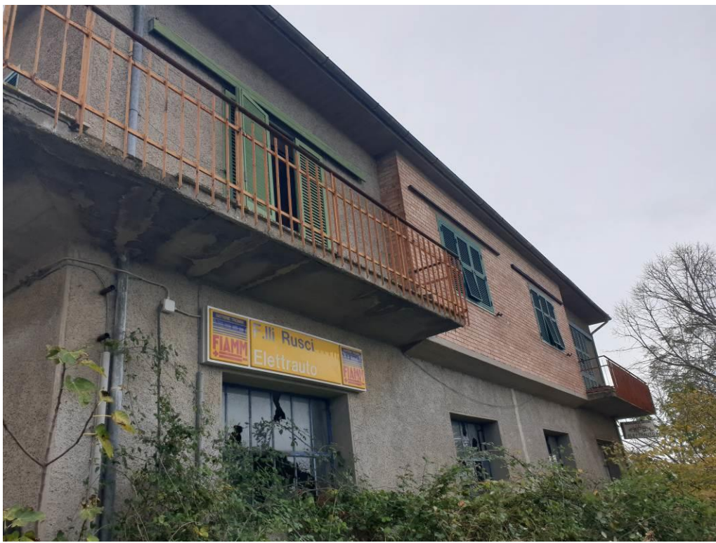
FOTO N.3- Vista prospetto immobile ad uso officina prospiciente la strada Provinciale n.18
