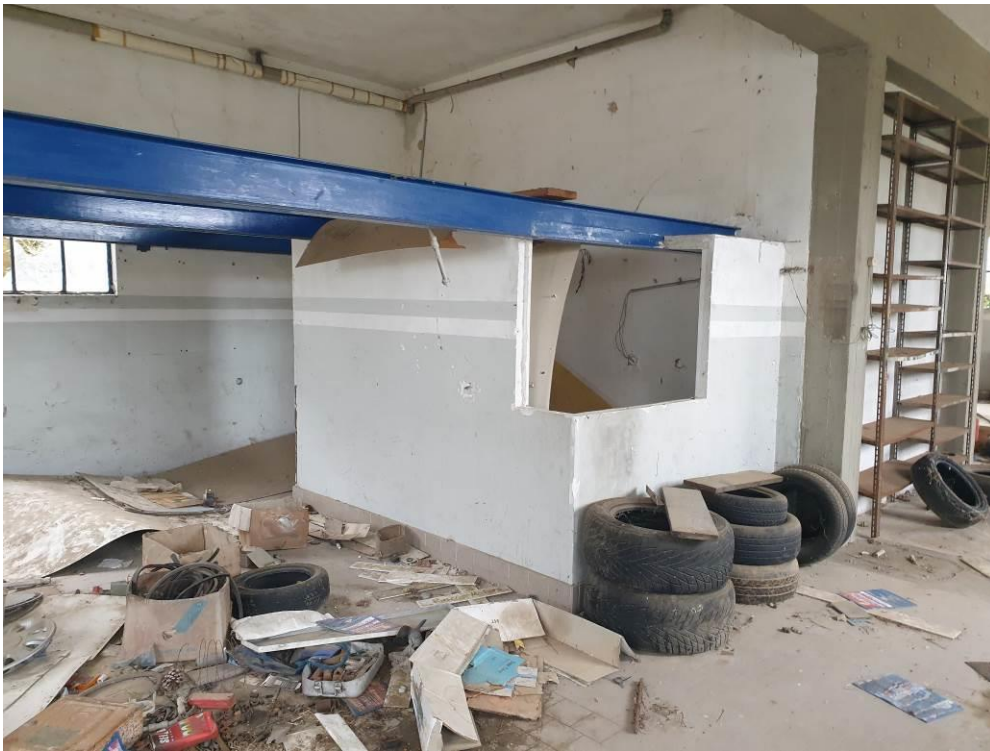
FOTO N.7 – Vista interna immobile ad uso officina
