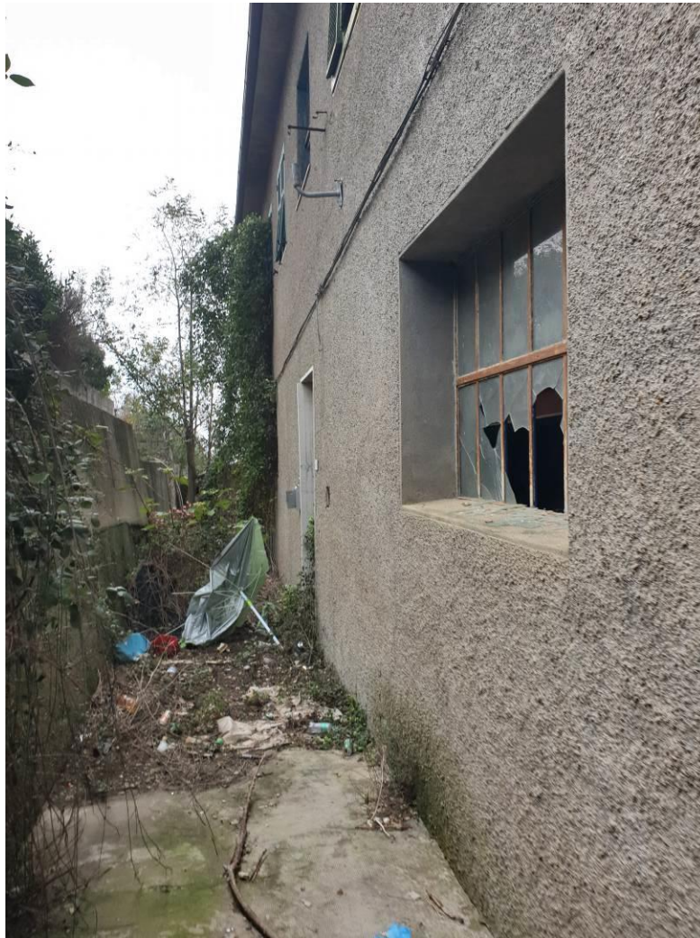
FOTO N.8 – Vista prospetto immobile corridoio laterale ingresso agli appartamenti al piano primo
