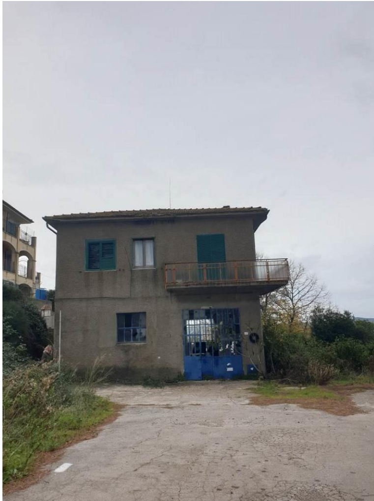
FOTO N.1 – Vista immobile ad uso officina dalla corte comune p.412 sub 1
