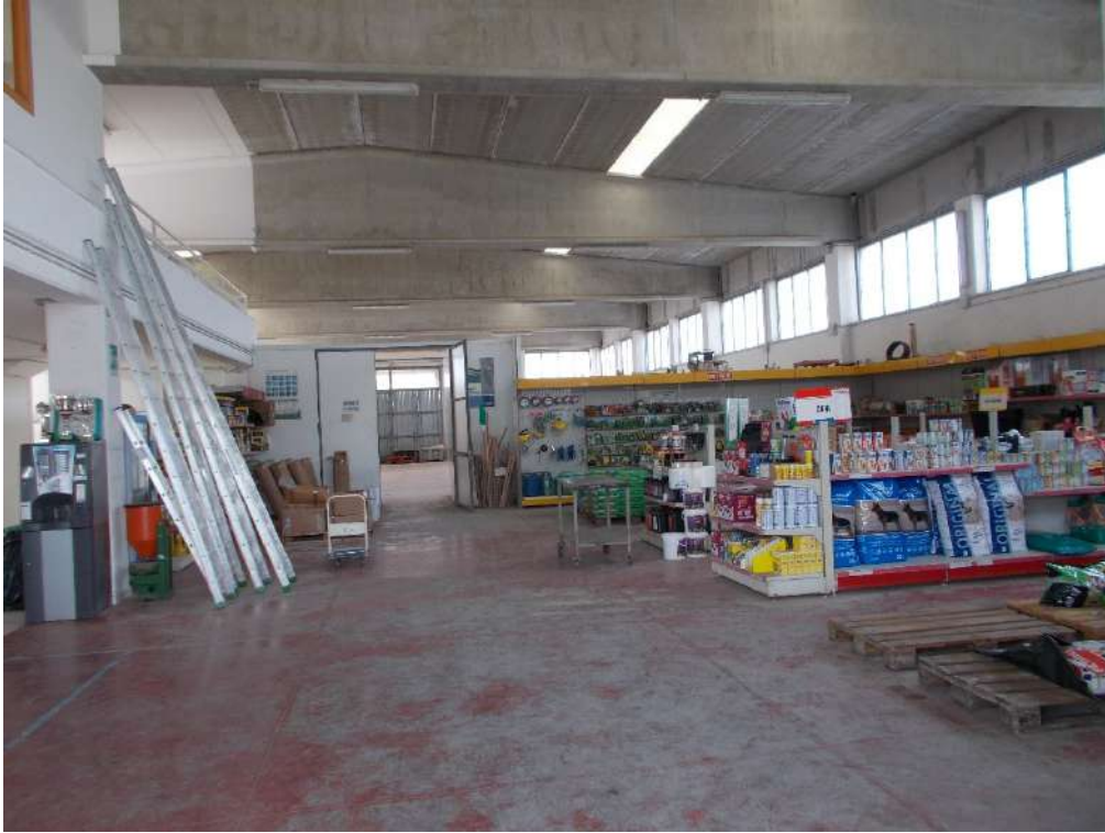
Interno fabbricato piano terra
