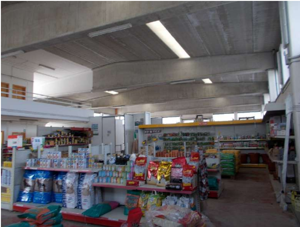
Interno fabbricato piano terra
