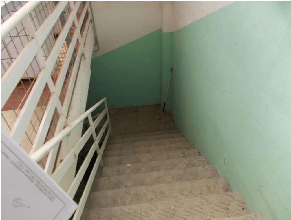
Accesso al piano interrato
