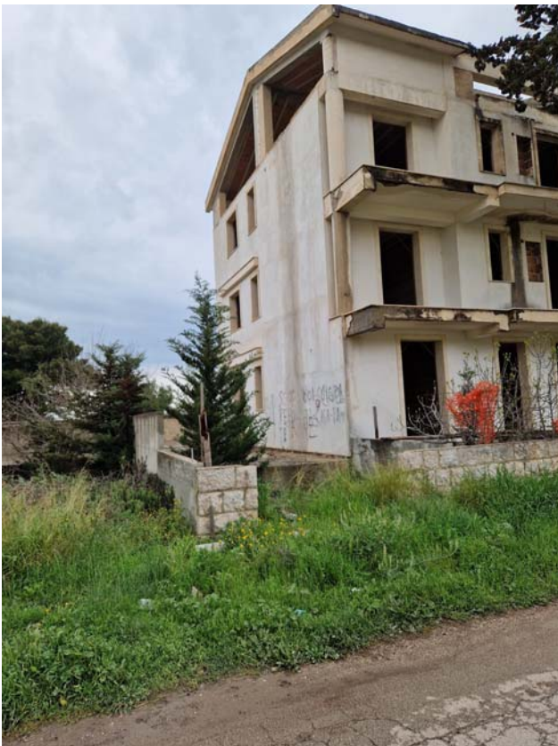
Vista laterale su rampa
