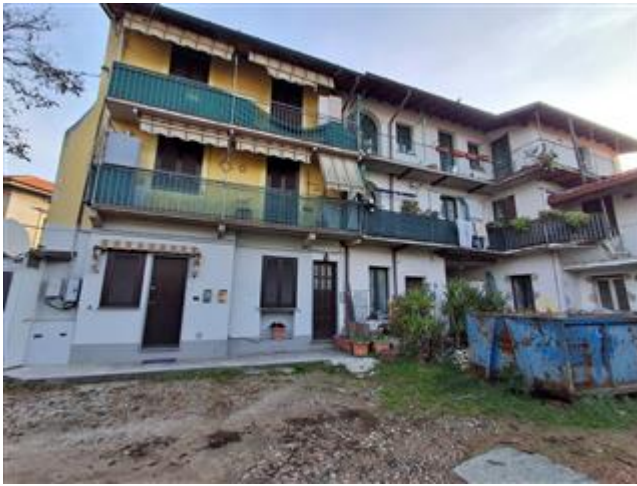
Vista da cortile comune
