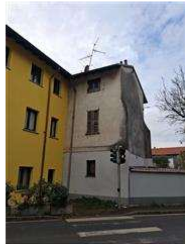
Vista retro immobile da Via Ristori
