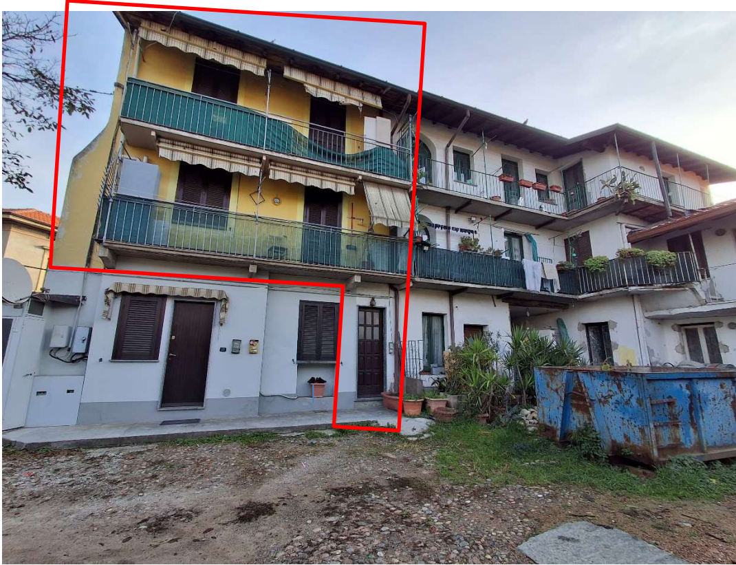
FOTO 1 - Vista esterna immobile dal cortile
