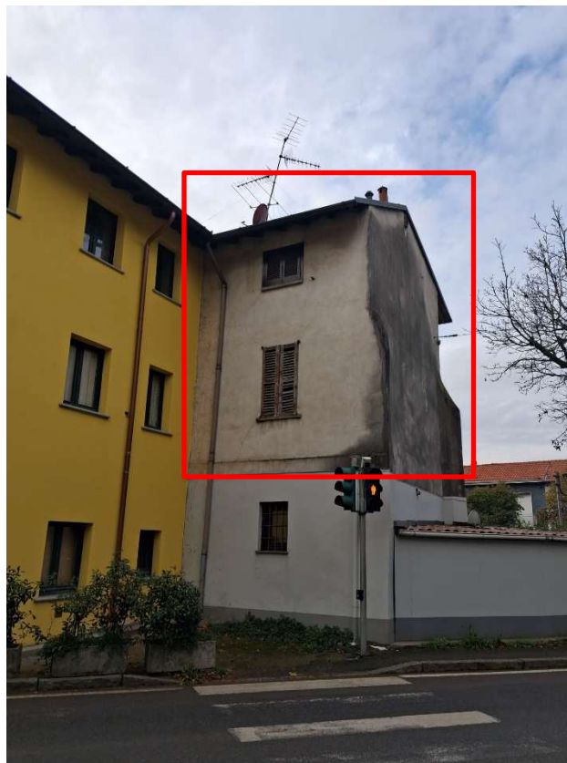
FOTO 2 - Vista esterna immobile da Via Ristori
