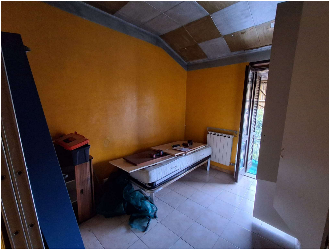
FOTO 7 - Vista interna Camera 2 a piano sottotetto
