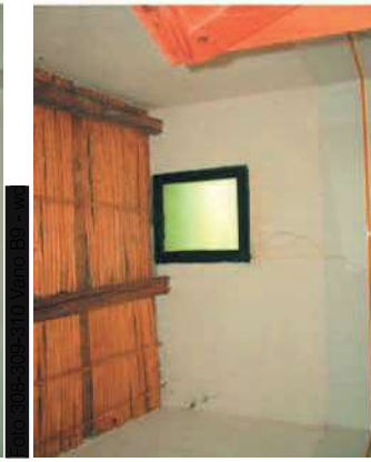
Foto 6 cancello di accesso
