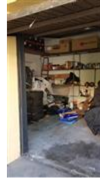
BOX AUTO DI CUI AL MAPPALE 752 SUB. 506 - PIANO TERRA
