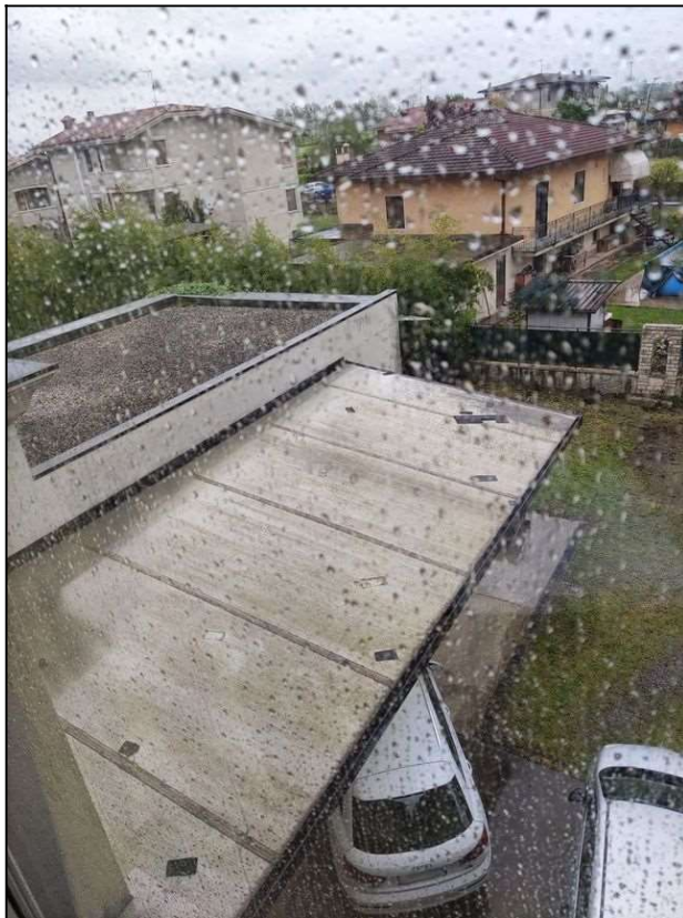
Fig. 9- Tettoia esterna vista dall'appartamento.
