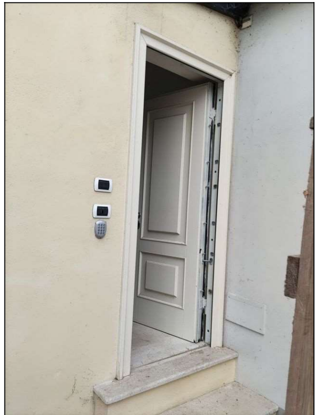
Fig. 10- Ingresso scale vicino tettoia.
