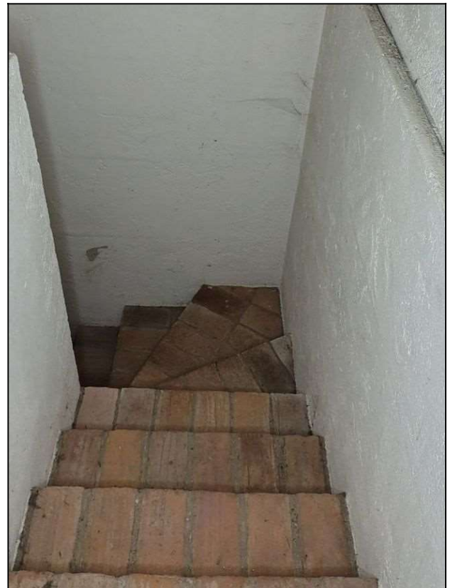
Fig. 40-Scale accesso cantina interrata.
