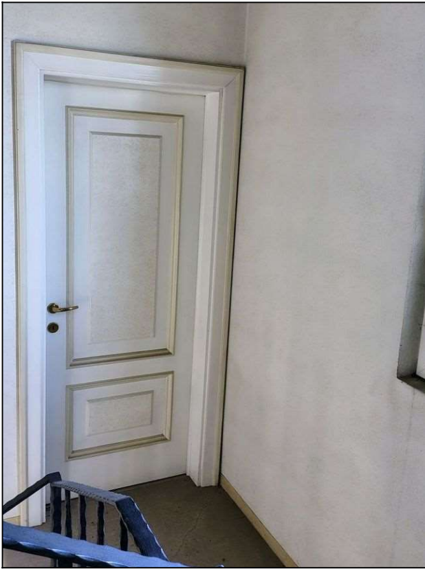
Fig. 37- Ingresso bagno servizio sulle scale.
