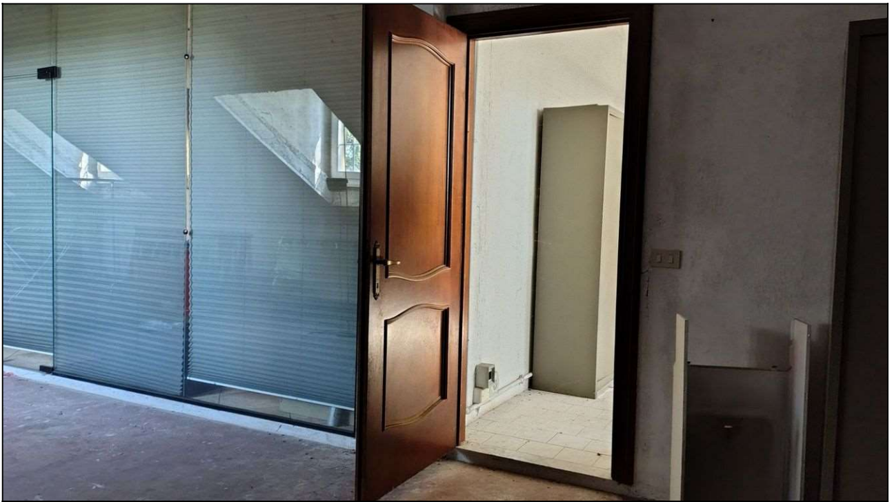
Fig. 34-Porta accesso seconda soffitta al terzo piano.
