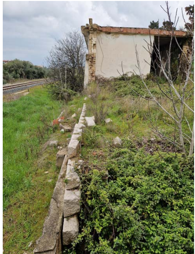
recinzione lungo il tracciato ferroviario
