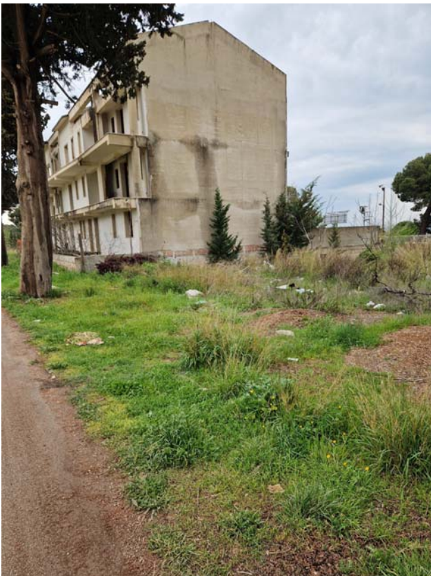
Fabbricato adiacente l'area
