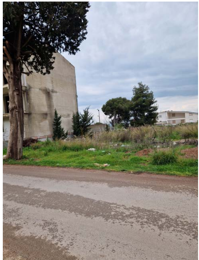
Fabbricato adiacente l'area
