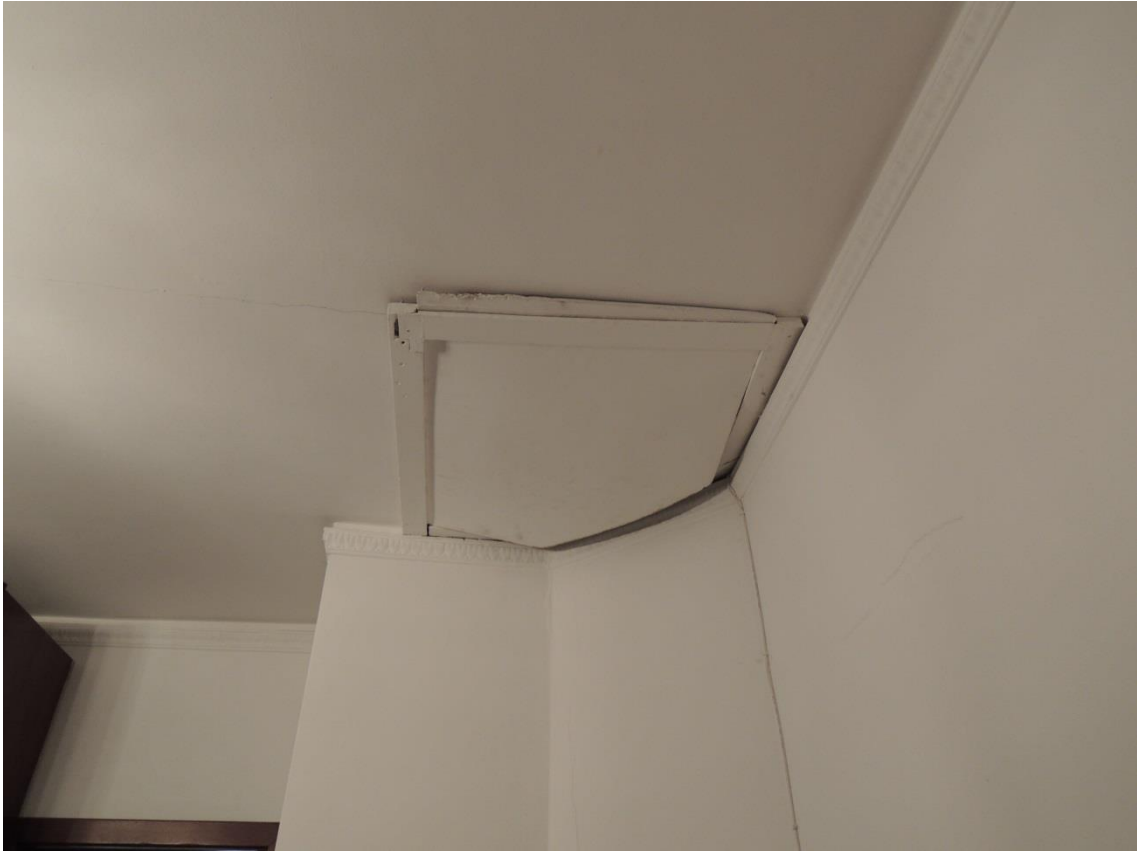
Figura 23 Botola di collegamento al sottotetto
