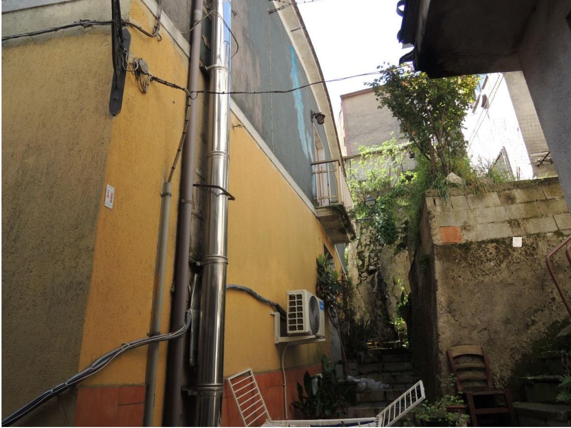
Figura 3 Prospetto laterale al fabbricato
