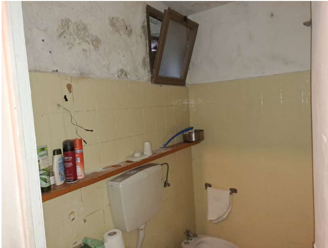
Foto 13 – W.c. piano seminterrato
