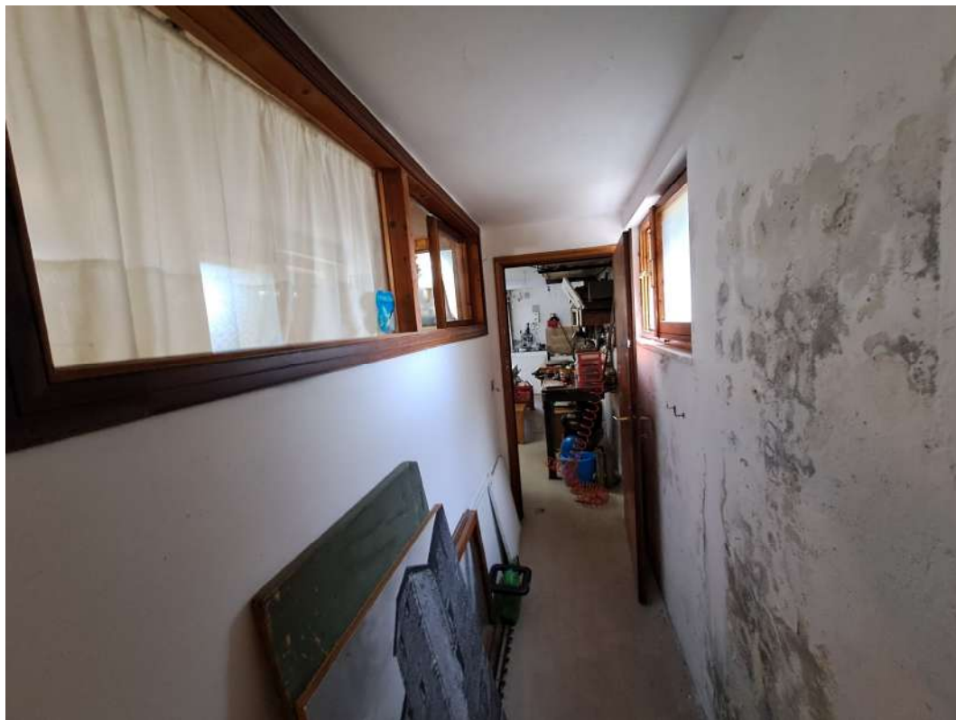
Foto 14 – Disimpegno piano seminterrato
