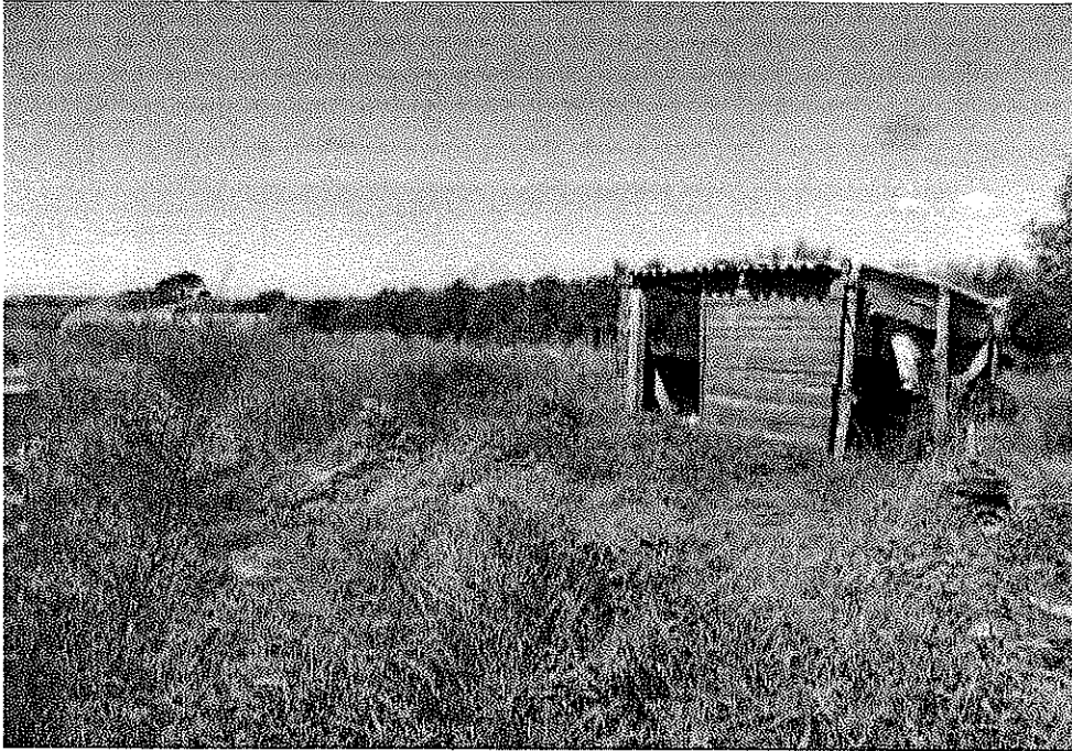
Foto 17 – Immobile “2A” – Deposito attrezzi in legno
