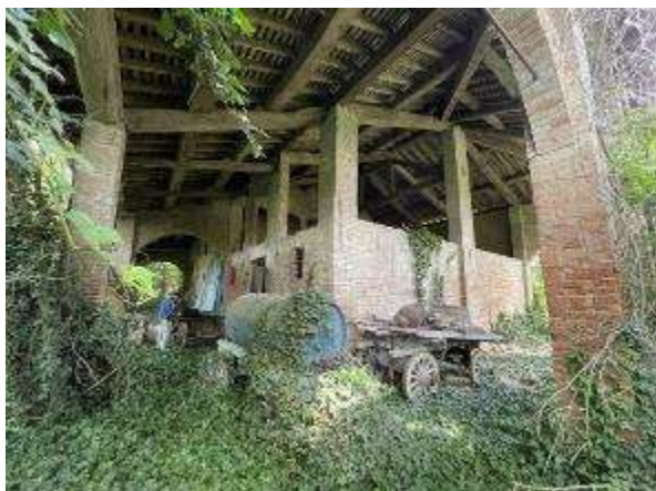
Foto 1 - casa colonica vista da S/E
