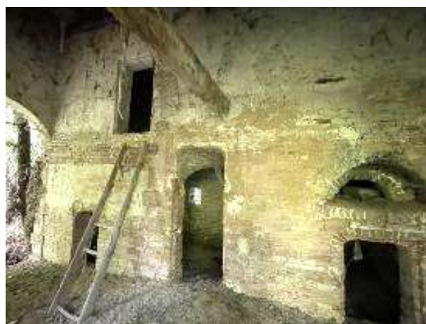
Foto 6 – Corpo Bassi Servizi
