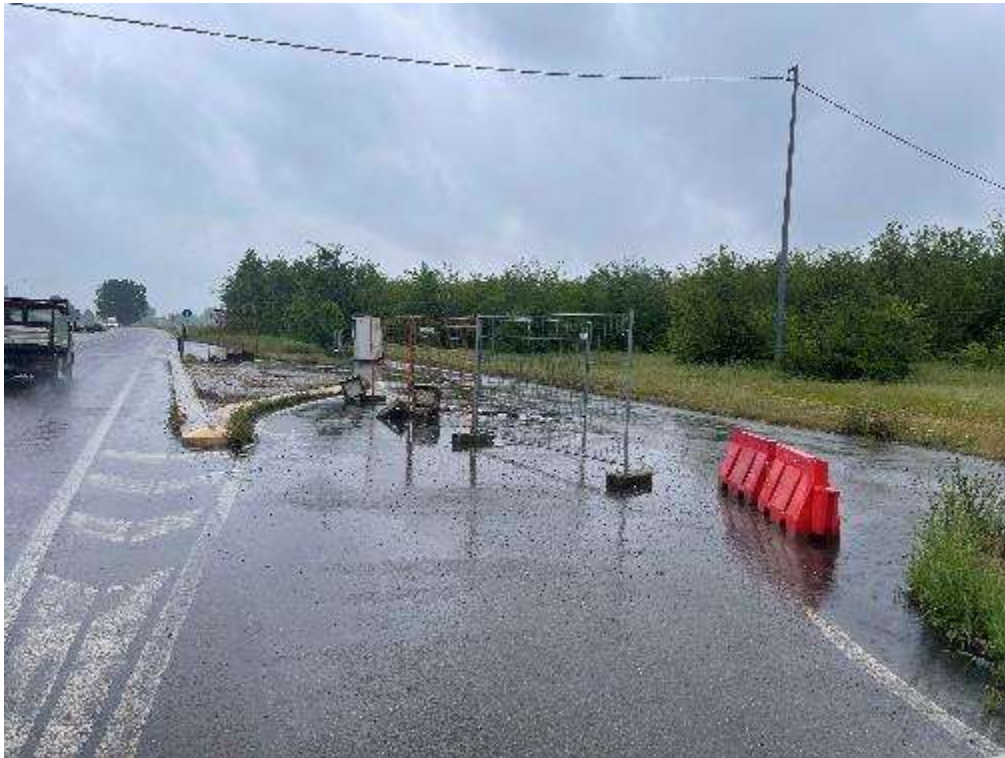
Foto 1- svincolo di accesso lotto
