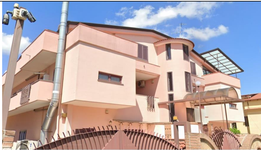
Foto 1 - prospetto dell'edificio su via P. Nenni
