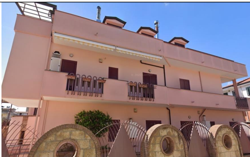
Foto 2 - prospetto dell'edificio su via Giovanni Amendola
